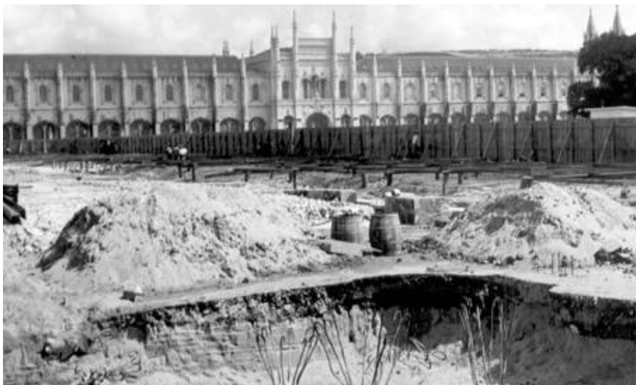
Centro Exposições Mundo Português - Construção da Fonte Luminosa, Lisboa (1939)
