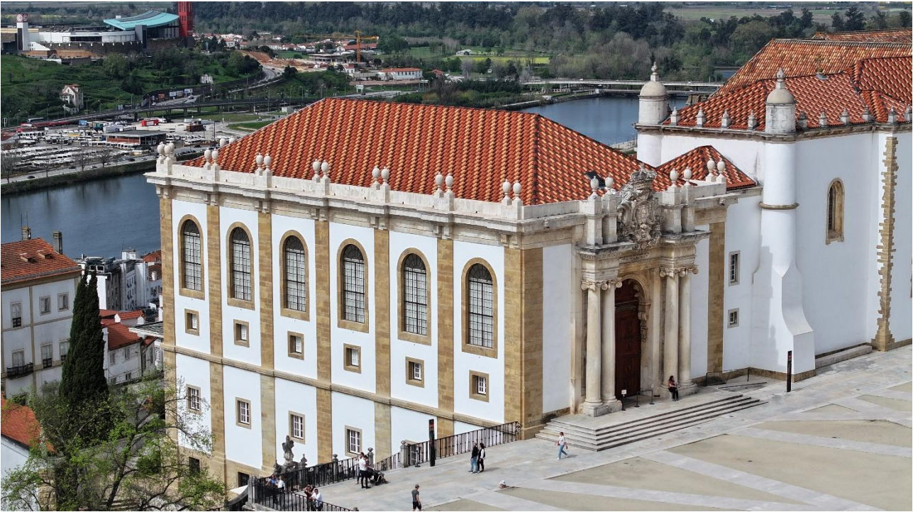
Empreitada de Reabilitação das Coberturas e Fachadas da Biblioteca Joanina da Universidade de Coimbra- Portugal
