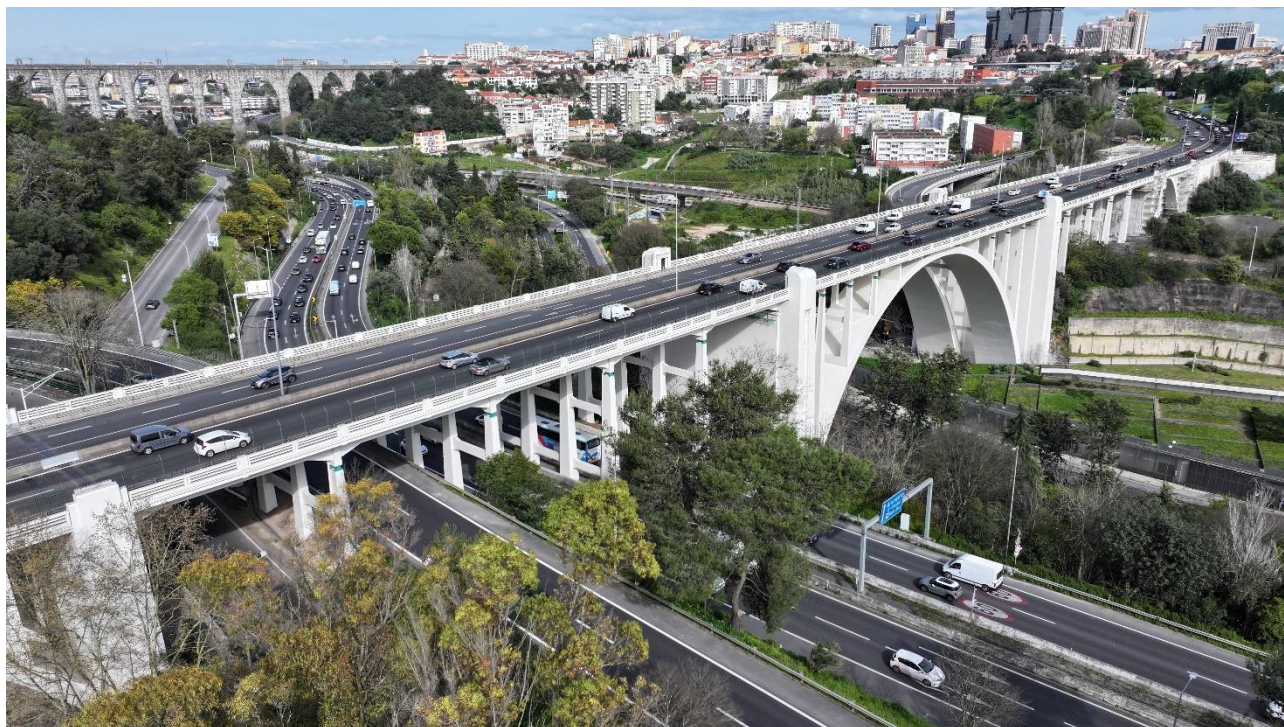
Empreitada de Reabilitação e Reforço Sísmico do Viaduto Duarte Pacheco em Lisboa - Portugal
