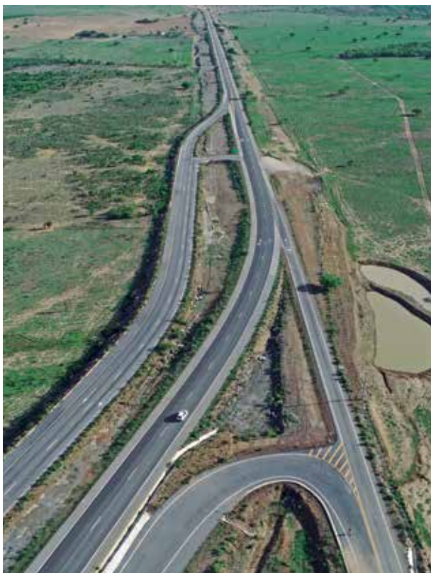
DNIT - Construction de la route BR235 ÉTAT DE BAHIA - BRÉSIL
