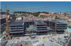
Construction de l'hôpital CUF Tejo LISBONNE - PORTUGAL
