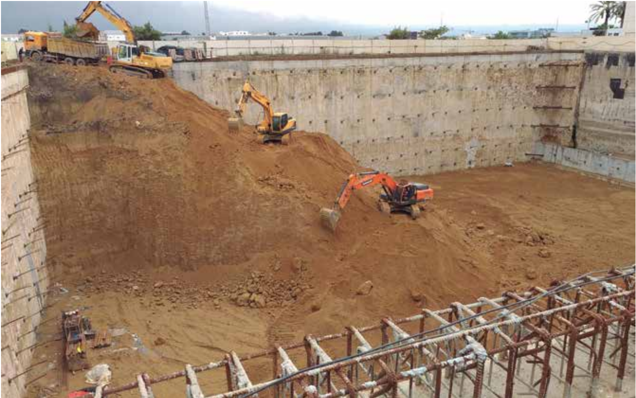
Groupe ETRHB - Fondations d'immeubles de bureaux BAB EZZOUAR - ALGÉRIE
