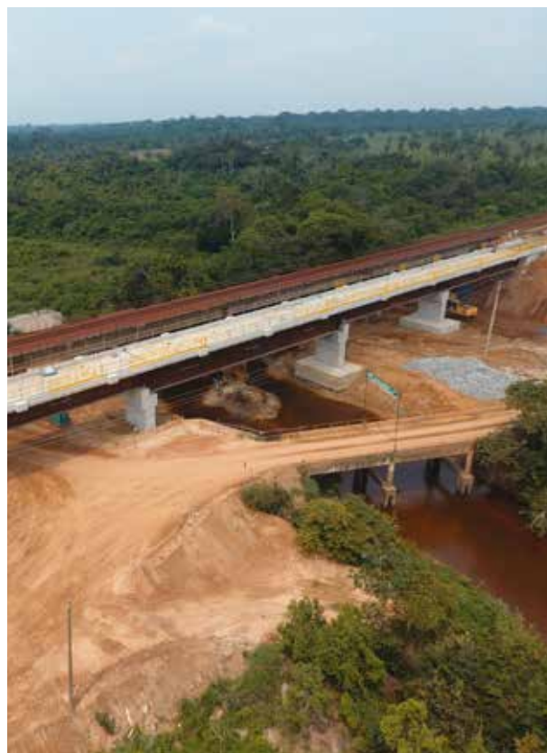
EMPA - SOMAFEL - CHEMIN DE FER DE CARAJÁS MONTAGE DE STRUCTURES MÉTALLIQUES DU PONT SUR LE FLEUVE FLECHEIRAS Marabá Pará - Brésil
