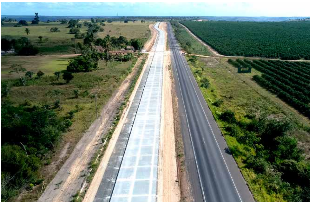
DNIT - DOUBLEMENT ET RÉNOVATION DE LA ROUTE BR101-BA État de Bahia - Brésil
