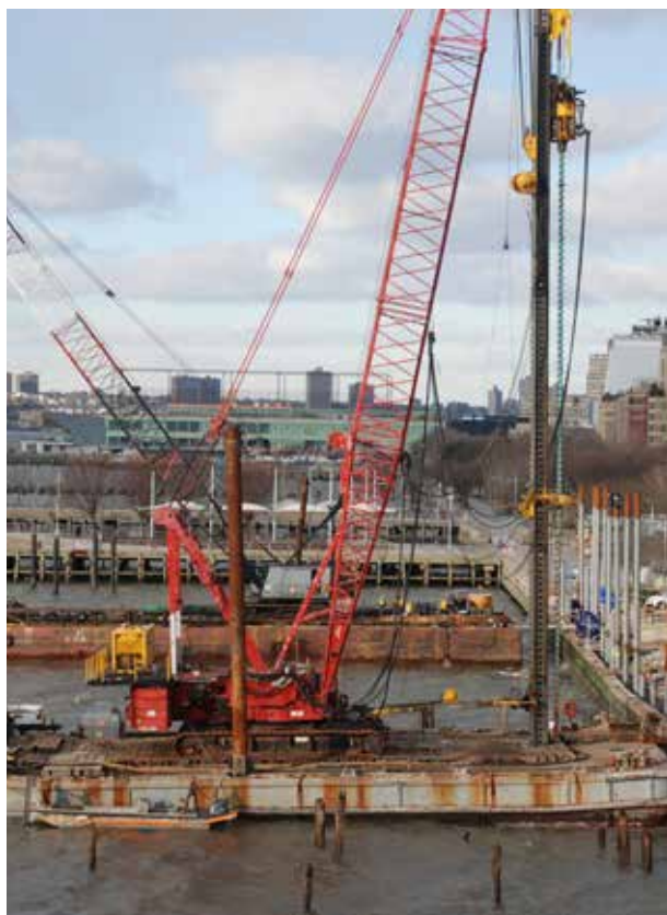
NYC EDC & SKANSKA USA BUILDING INC - INSTALLATION DE PONTONS FLOT-TANTS POUR FERRY BOATS - RÉALISATION DE PIEUX MÉTALLIQUES - FLEUVE HUDSON New-York - EUA
