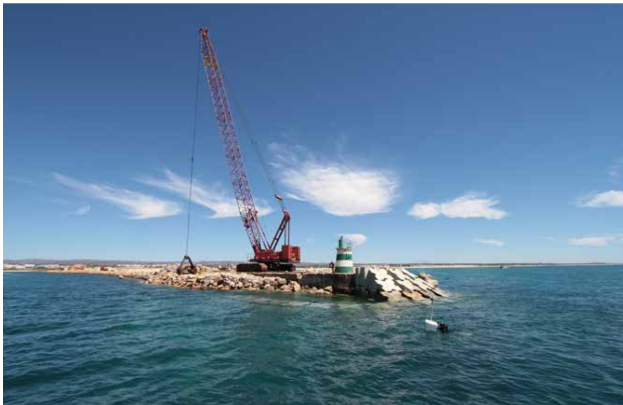
DGRM - RÉHABILITATION DE LA JETÉE ORIENTALE DU PORT DE TAVIRA Portugal
