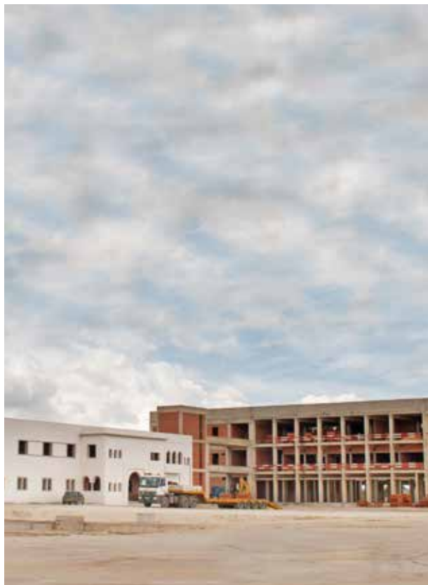
AGA - INSTALLATIONS ET ÉQUIPEMENTS D'EXPLOITATION DE L'AUTOROUTE EST-OUEST - LOT OUEST Algérie
