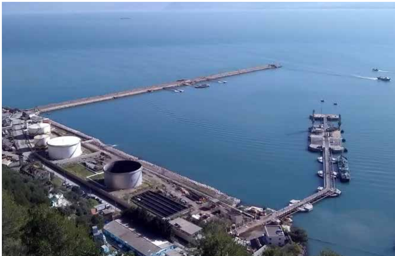
EPB - RÉHABILITATION DES POSTES 1-2-3 DU PORT PÉTROLIER Bejaia - Algérie
