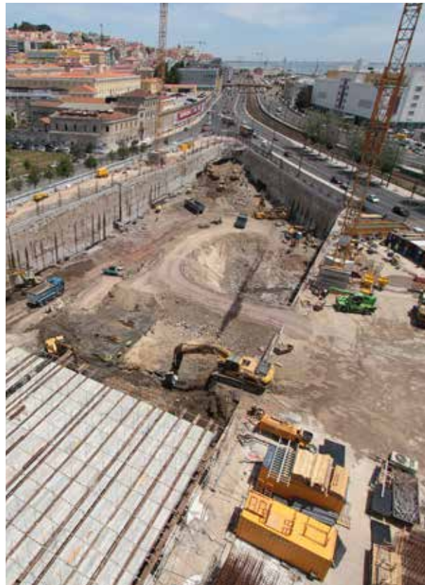
IMO HEALTH – EXCAVACIÓN, CONTENCIÓN PERIFÉRICA Y ESTRUCTURA PISO 0 – HOSPITAL CUF TEJO Lisboa - Portugal
