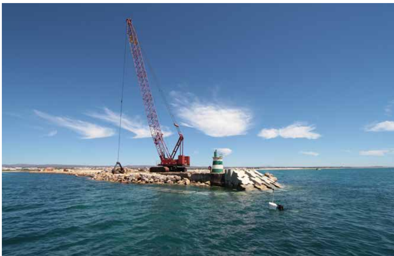
DGRNSS – REHABILITACIÓN DEL MUELLE DE LA BARRA DA TAVIRA Portugal
