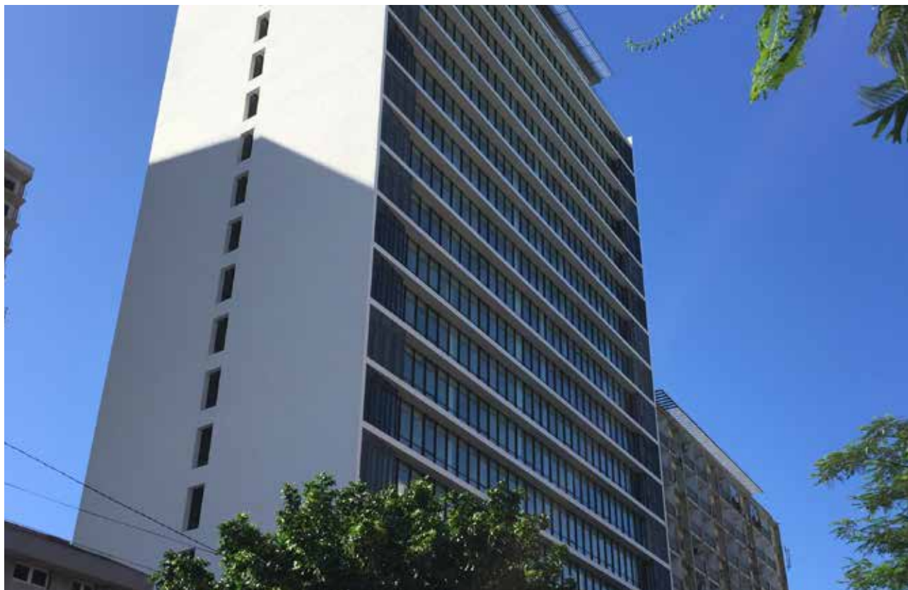
IMOINVEST - EDIFÍCIO JN02 Maputo - Mozambique
