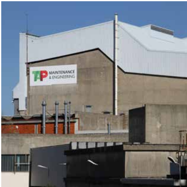
CAMPUS TAP - FM & Manutenção Lisboa - Portugal
