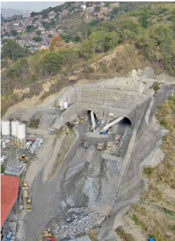
MINISTERIO DEL PODER POPULAR PARA EL TRANSPORTE TERRESTRE CONSTRUCCIÓN DEL TÚNEL BARALT Caracas - Venezuela
