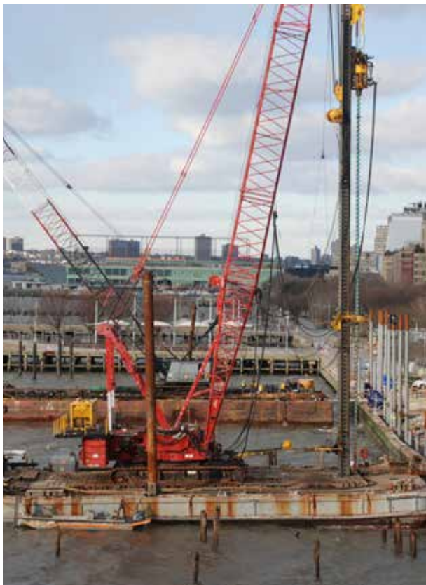
NYC EDC & SKANSKA USA BUILDING INC - INSTALACIÓN DE MUELLES FLOTANTES PARA FERRY BOATS - EJECUCIÓN DE PILOTES METÁLICOS - RIO HUDSON Nueva York - EE. UU.
