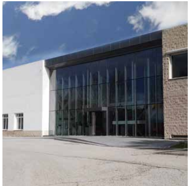
GRUNDFOS - FM & Manutenção Madrid - Espanha
