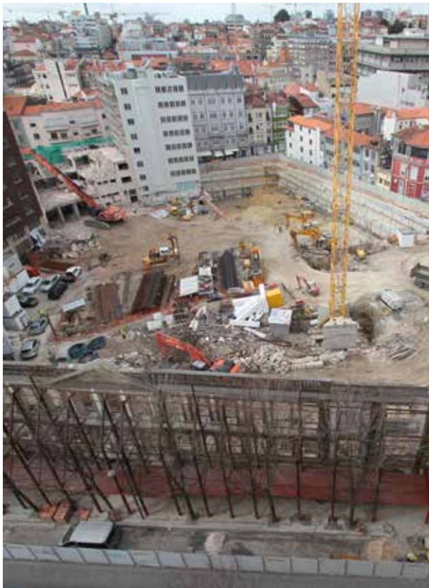
INTERFUNDOS – MANZANA D. JOÃO I – DEMOLICIÓN, CONTENCIÓN DE FACHADA, EXCAVACIÓN Y CONTENCIÓN PERIFÉRICA Porto - Portugal
