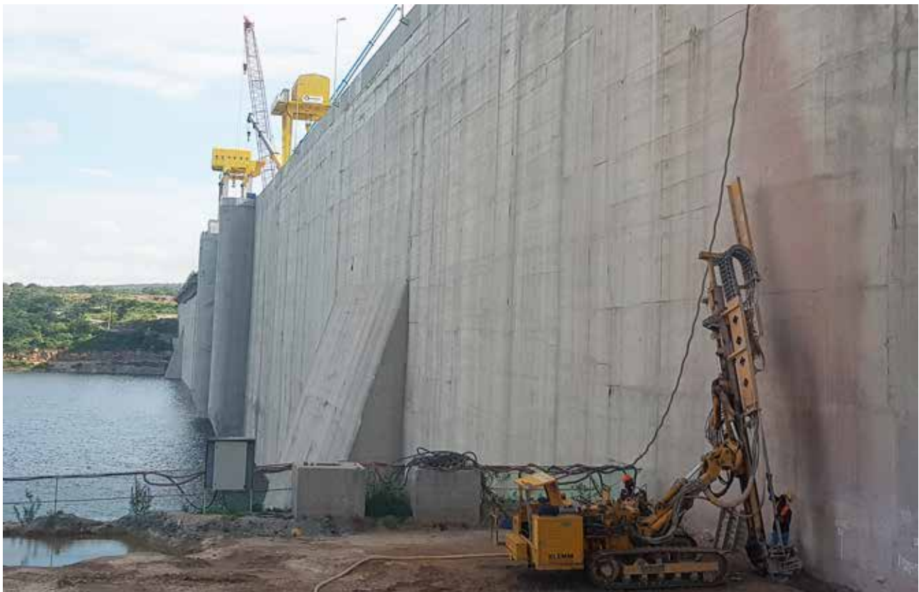
CONSTRUTORA NORBERTO ODEBRECHT – CONTRATA A.H. LAUCA – PRESTACIÓN DE SERVICIOS DE PERFORACIÓN E INYECCIÓN PARA IMPERMEABILIZACIÓN Y PERFORACIÓN PARA DRENAJE
