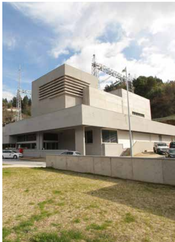
EDP - REFORÇO DE POTÊNCIA DE SALAMONDE Vieira do Minho - Portugal
