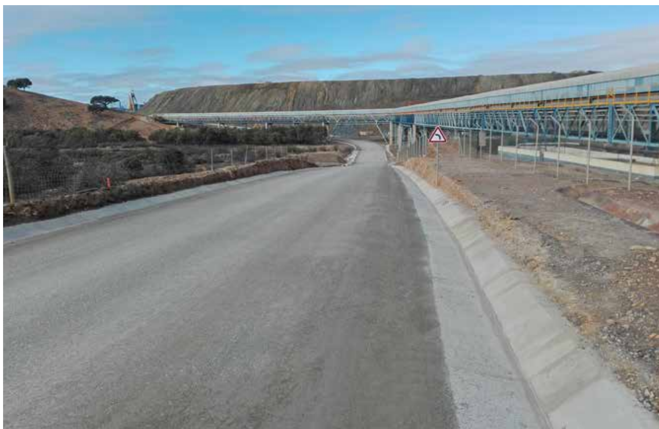
SOMINCOR - ESTRADA DE LIGAÇÃO ENTRE A ZONA INDUSTRIAL - BARRAGEM DO CERRO DO LOBO Castro Verde - Portugal
