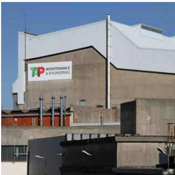
CAMPUS TAP - FM & Manutenção Lisboa - Portugal
