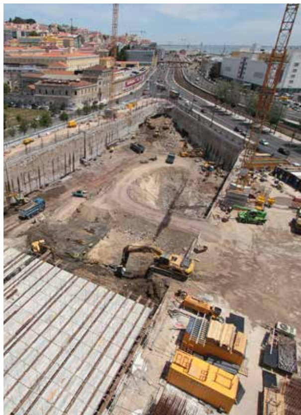
IMO HEALTH ESCAVAÇÃO, CONTENÇÃO PERIFÉRICA E ESTRUTURA PISO 0 - HOSPITAL CUF TEJO Lisboa - Portugal
