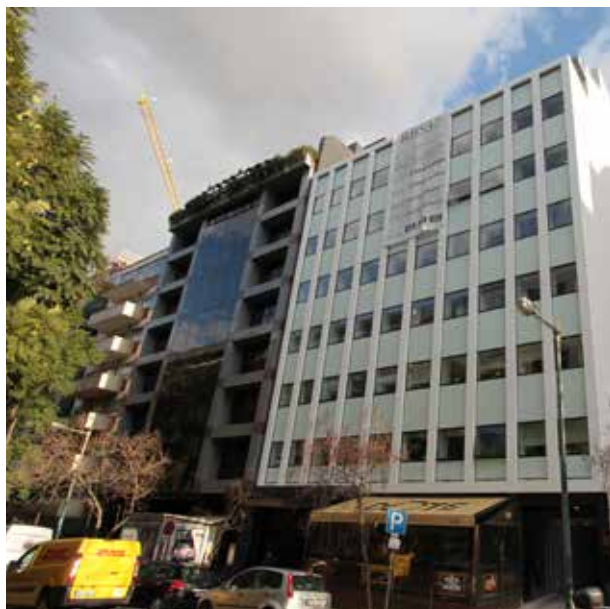
NARCIPROMOV - REMODELAÇÃO DE EDIFÍCIO DE ESCRITÓRIOS Lisboa - Portugal
