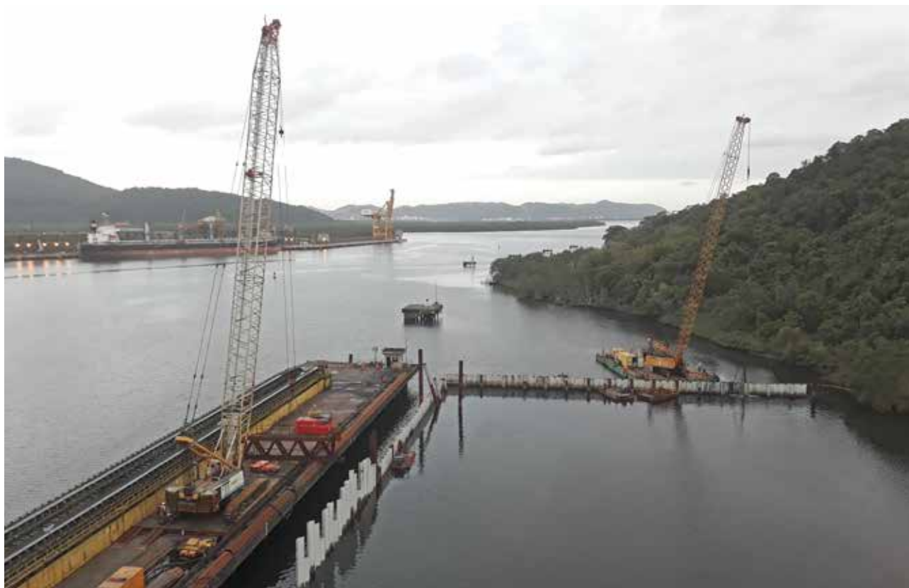
VLI - CONTENÇÃO EM ESTACAS PRANCHA CANAL PIAÇAQUERA Cubatão - Brasil
