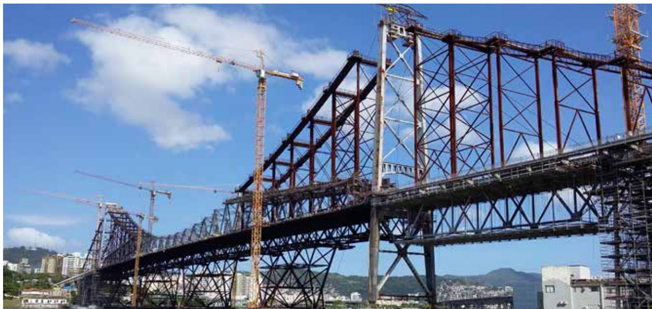
DEINFRA - RESTAURAÇÃO E REABILITAÇÃO DA PONTE HERCÍLIO LUZ Florianópolis - Brasil
