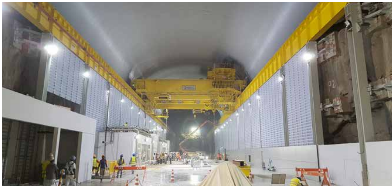
CONSTRUTORA NORBERTO ODEBRECHT - CENTRAL HIDROELECTRICA DE LAÚCA - MONTAGEM DE ESTRUTURAS METÁLICAS DA CASA DA FORÇA Laúca - Angola
