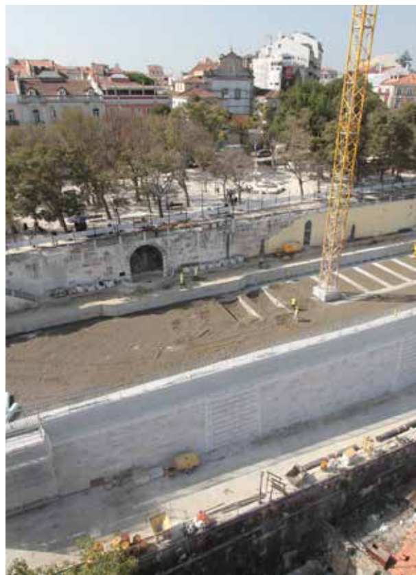
CML ESTABILIZAÇÃO DO MIRADOURO DE SÃO PEDRO DE ALCÂNTARA Lisboa - Portugal
