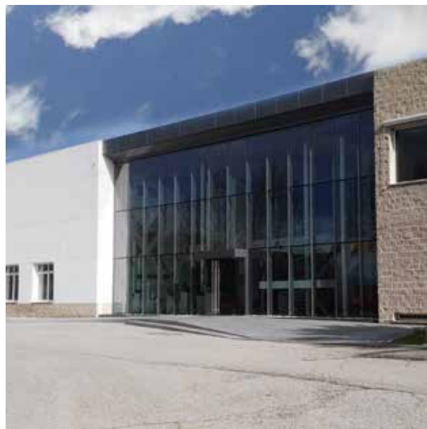
GRUNDFOS - FM & Manutenção Madrid - Espanha
