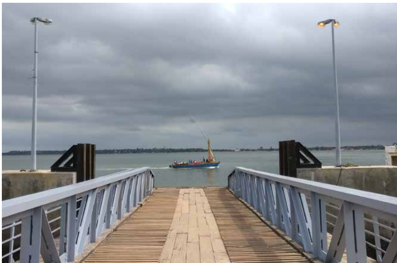
CFM - REPARAÇÃO DE PONTE CAIS Maputo - Moçambique
