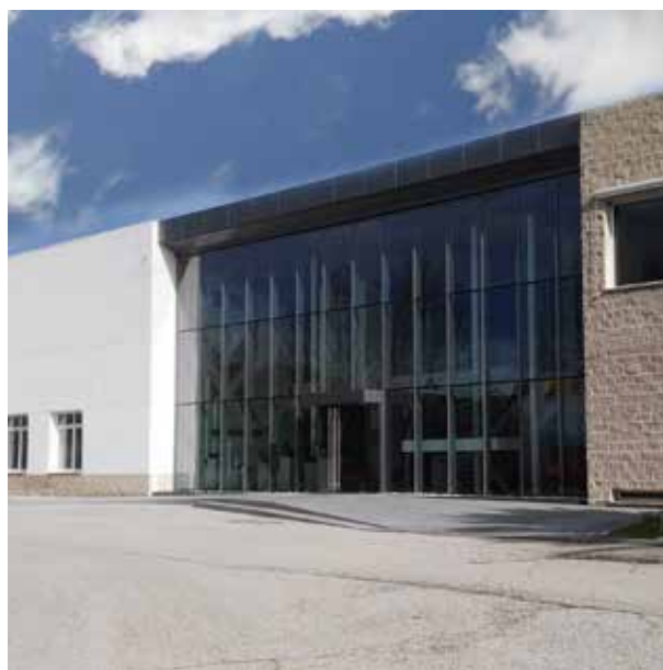
GRUNDFOS - FM & Manutenção Madrid - Espanha
