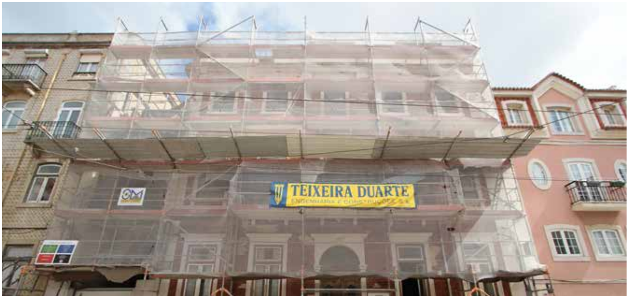
HALCYON - RECUPERAÇÃO E ALTERAÇÕES DE EDIFÍCIO NA LAPA Lisboa - Portugal
