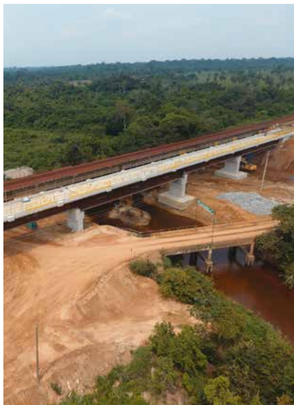
EMPA - SOMAFEL - ESTRADA DE FERRO DE CARAJÁS MONTAGEM DE ESTRUTURAS METÁLICAS DA PONTE SOBRE RIO FLECHEIRAS Marabá Pará - Brasil
