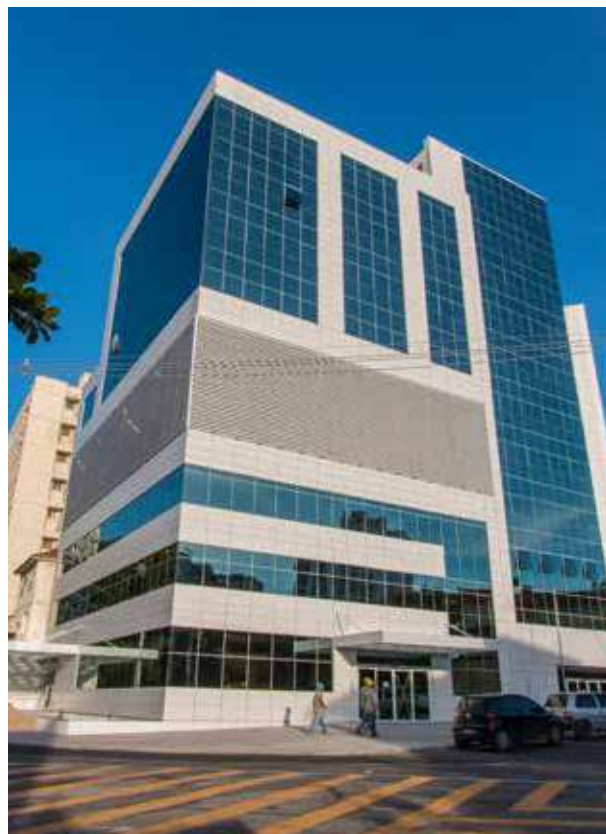
HCHN - EDIFÍCIO HOSPITALAR UNIDADE IV Niterói - Brasil
