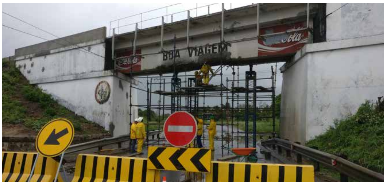
CFM - REABILITAÇÃO DA PONTE DA MANHIÇA Moçambique
