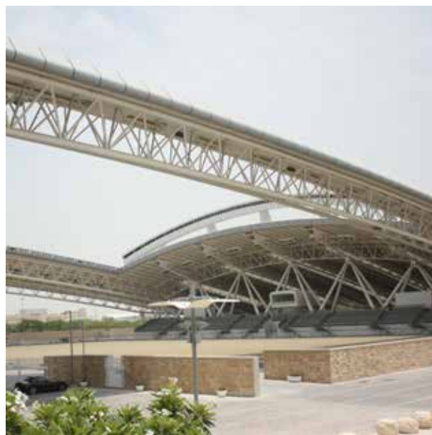
AL SHAQAB EQUESTRIAN CENTRE FM&Manutenção Doha - Qatar
