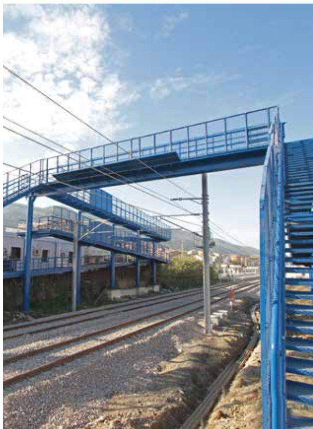
MODERNIZAÇÃO DA LINHA FERREA - TROÇO THENIA TIZI OUZOU - ESTAÇÃO DE TDEMAT - PASSAGEM SUPERIOR METALICA Argélia
