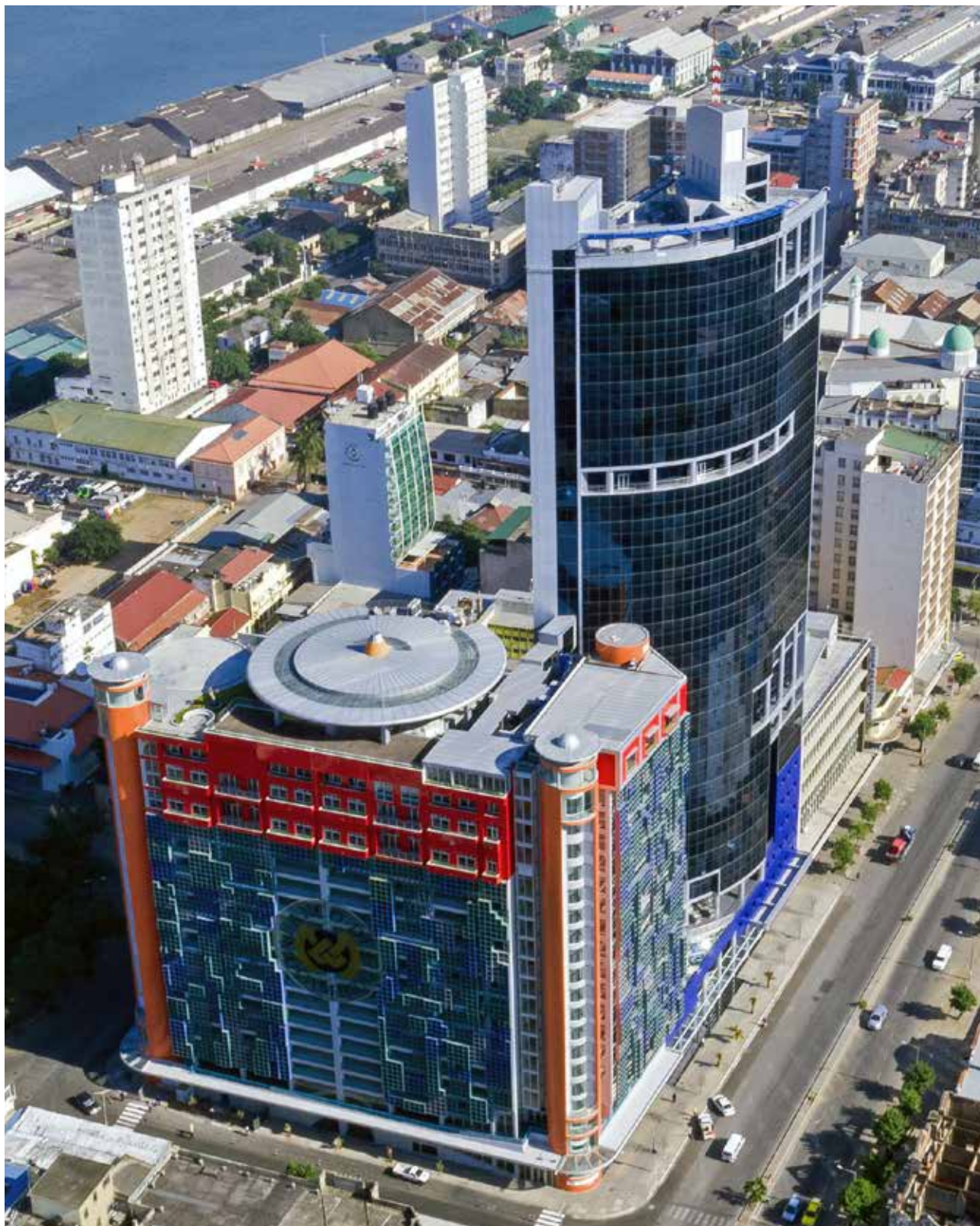
BANCO DE MOÇAMBIQUE - COMPLEXO DE 3 EDIFÍCIOS Maputo - Moçambique
