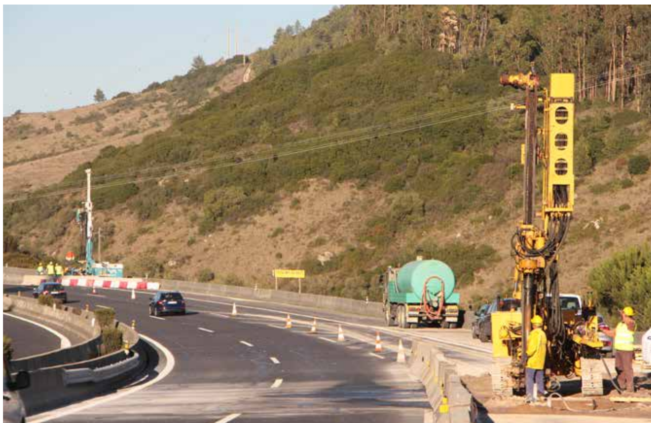
BRISA CONSOLIDAÇÃO DE ATERRO KM 25+700 DA A9 - CREL - INJEÇÕES DE CONSOLIDAÇÃO São Julião Do Tojal - Portugal
