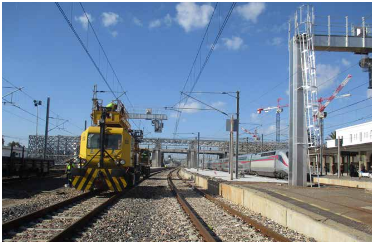
ONCF - ESTAÇÃO TERMINAL DE KENITRA Marrocos
