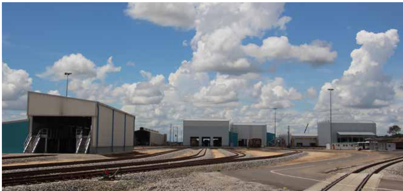
CLN - OFICINAS DE MANUTENÇÃO DE LOCOMOTIVAS Nacala - Moçambique
