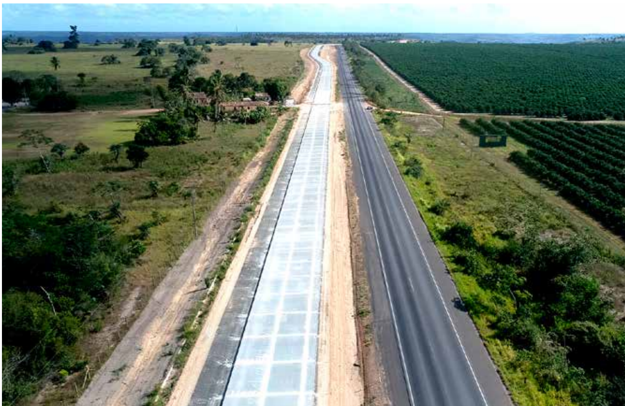
DNIT - DUPLICAÇÃO E RENOVAÇÃO DA RODOVIA BR101-BA Estado da Bahia - Brasil
