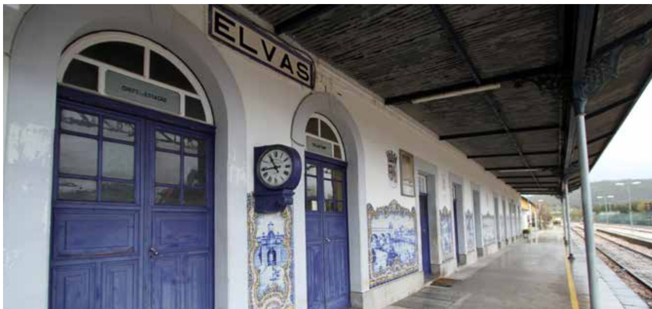
INFRAESTRUTURAS DE PORTUGAL - MODERNIZAÇÃO DA LINHA DO LESTE TROÇO ELVAS-FRONTEIRA Elvas - Portugal
