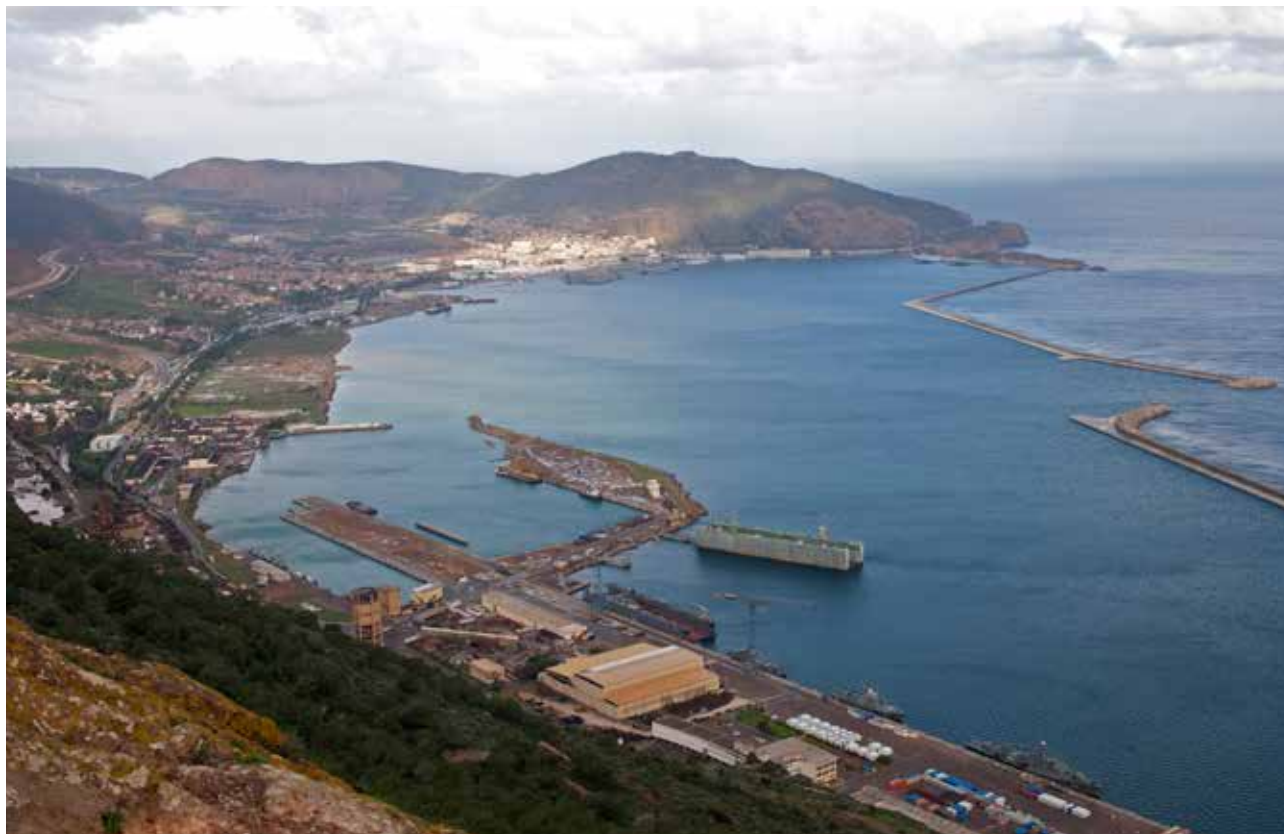
ECRN - CONSTRUÇÃO DE ELEVADOR DE NAVIOS - BASE NAVAL DE MERS EL KEBIR Argélia
