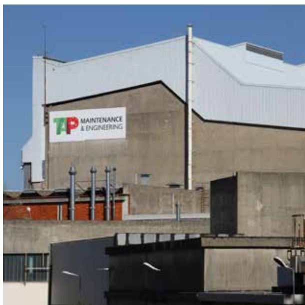
CAMPUS TAP - FM & Manutenção Lisboa - Portugal
