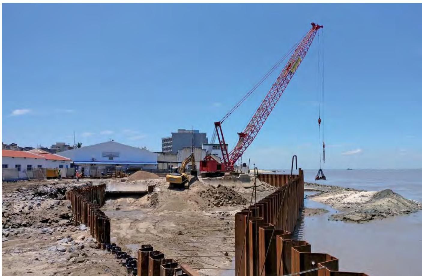
CFM - Trabajos de geotecnia Puerto de Beira | Mozambique
