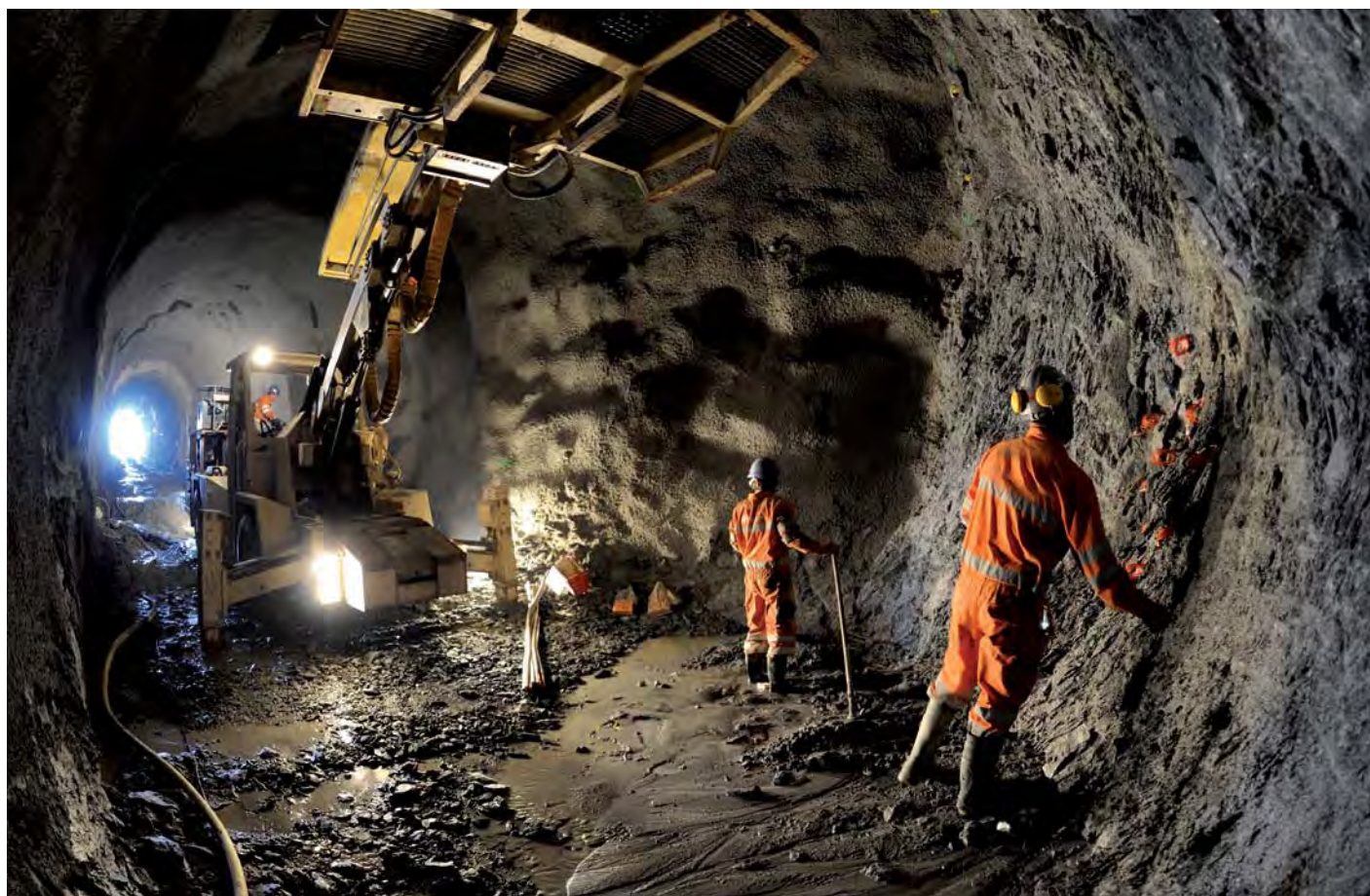
Ferrovial / MSF - Construcción de la Central de aspiración y forzada por debajo de la cuota 800 - CV04 Sabrosa | Portugal
