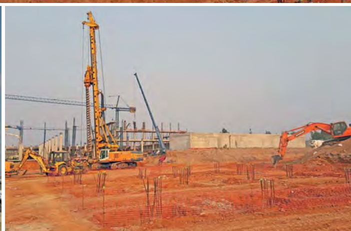
OMATAPALO - Cimentaciones indirectas del edificio Talatona 2 Luanda | Angola
