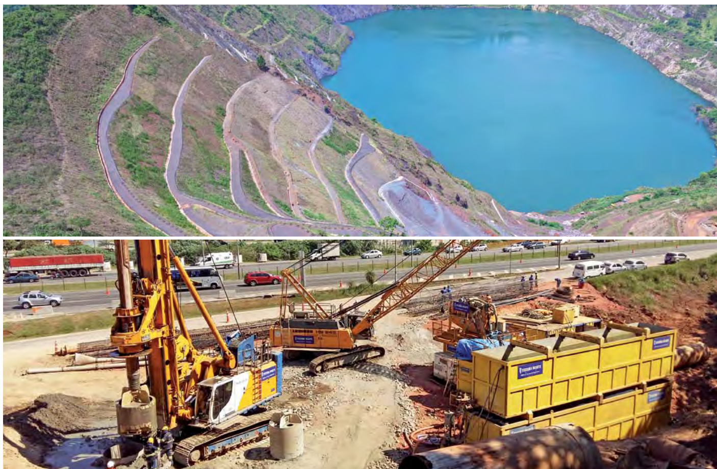
VALE - Estabilización de taludes en el sector Cava Oeste - Mina de Águas Claras, Nova Lima Minas Gerais | Brasil
