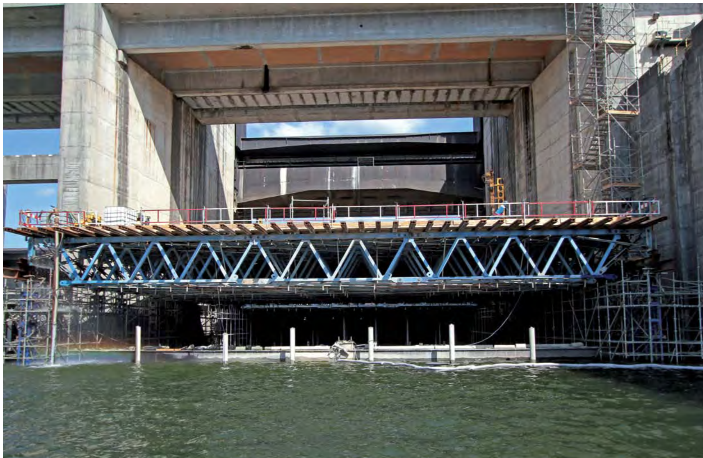
Presa de Crestuma - Concepción y montaje de una plataforma para la ejecución de trabajos de Geotecnia Oporto | Portugal
