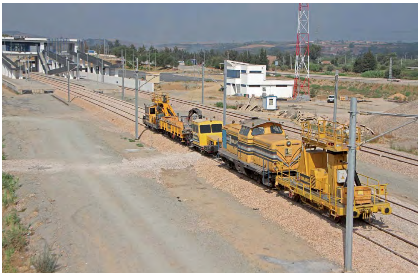
ANESRIF - Modernización de la línea entre Thénia y Tizi Ouzou y su electrificación hasta Oued Aissi Argelia
