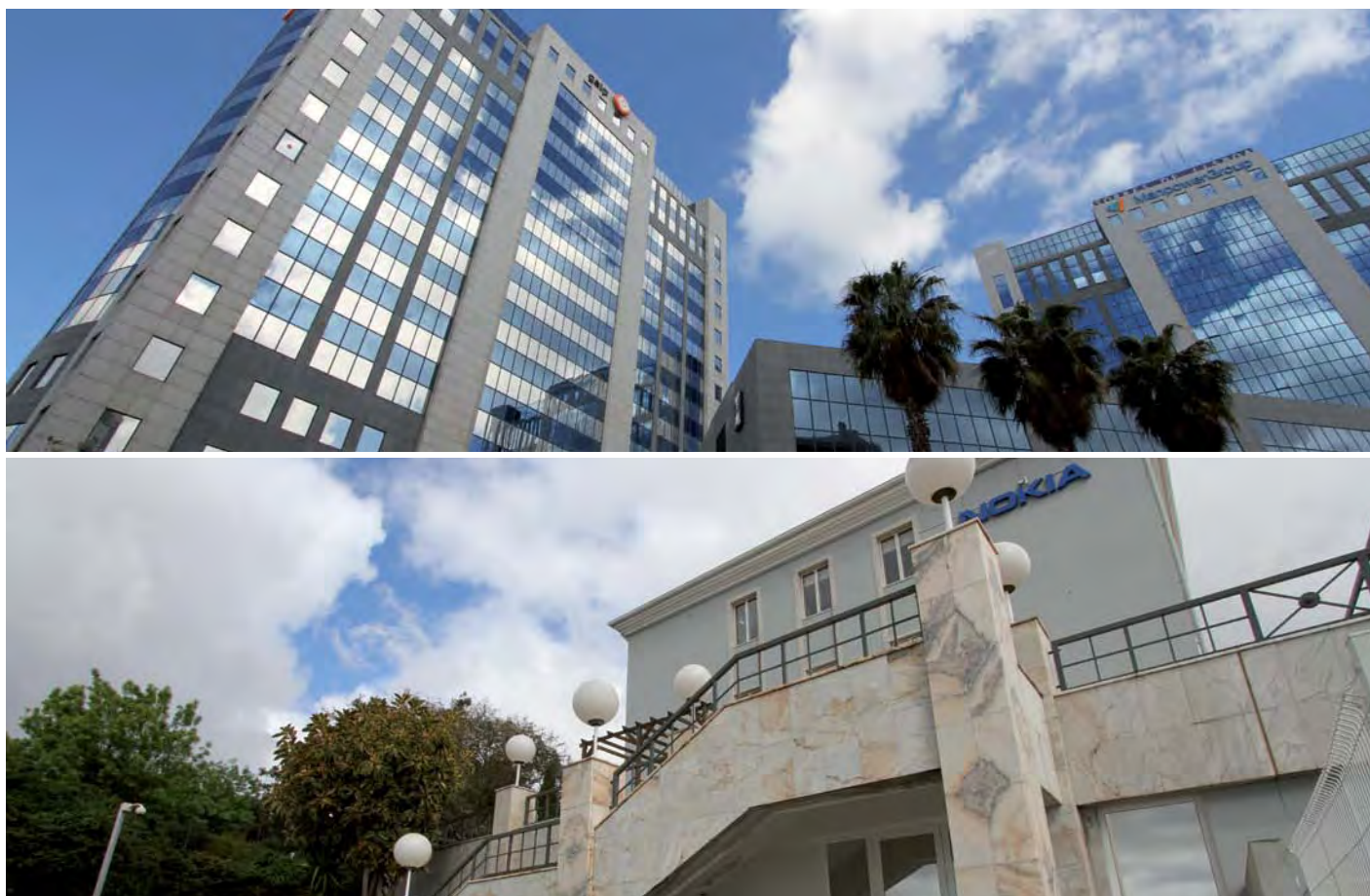
GALP – Contrato de mantenimiento de las instalaciones y equipos – Torres de Lisboa Lisboa | Portugal
