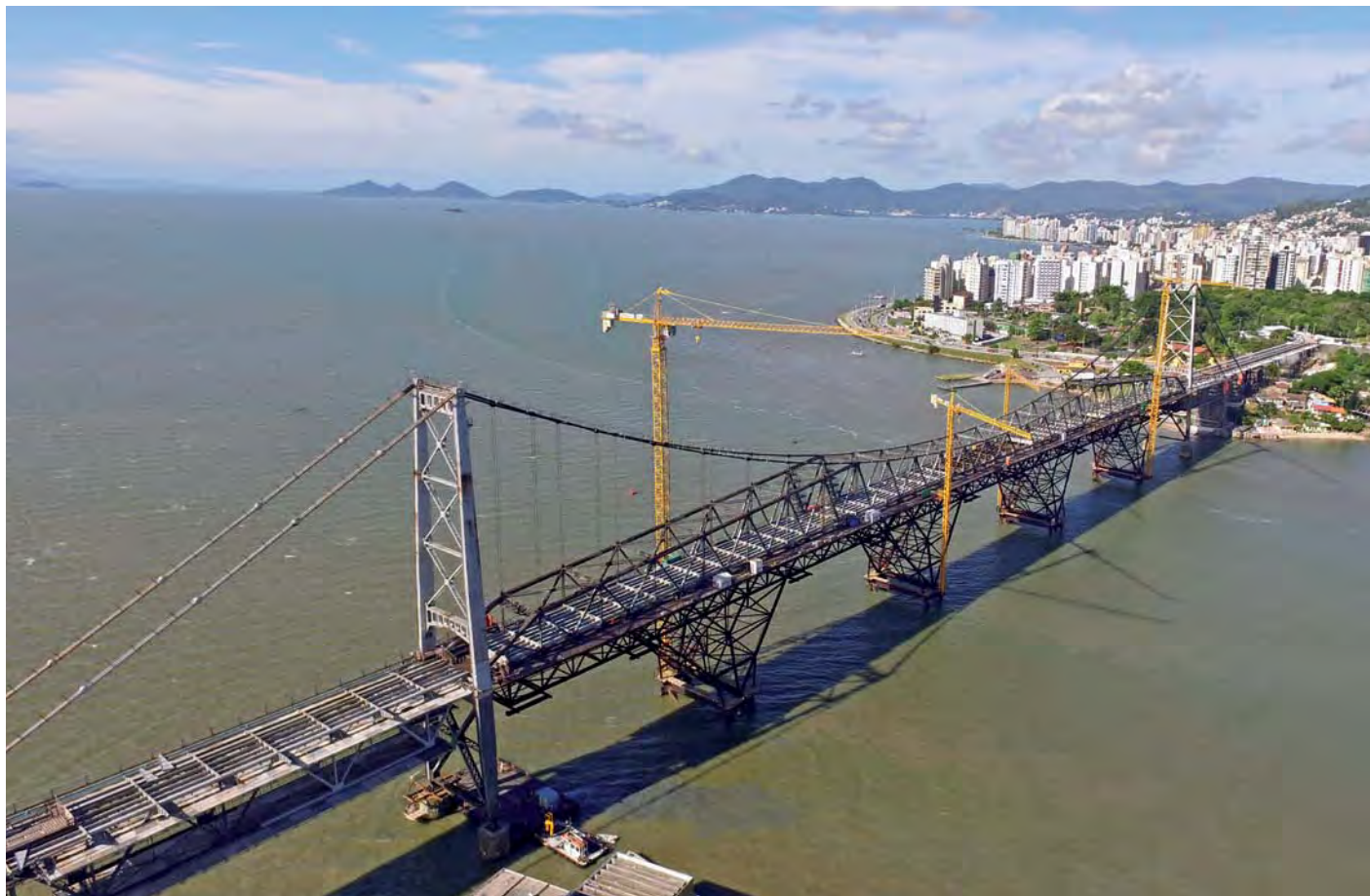
DEINFRA – Restauración y rehabilitación del puente Hercílio Luz Florianópolis | Brasil
