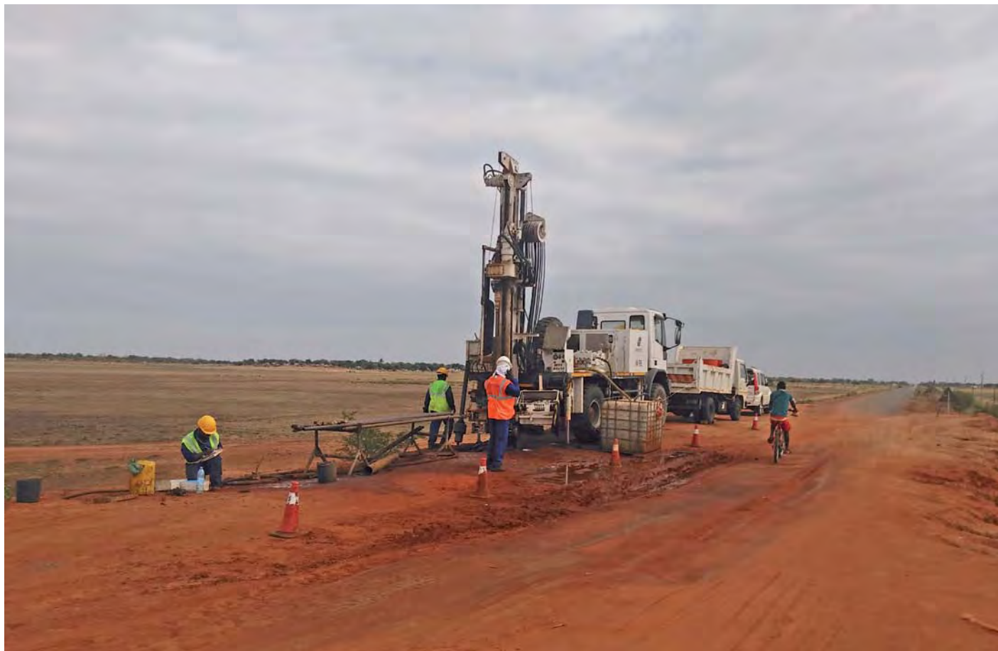
ANE - Trabajos de sondeos Provincia de Gaza | Mozambique
