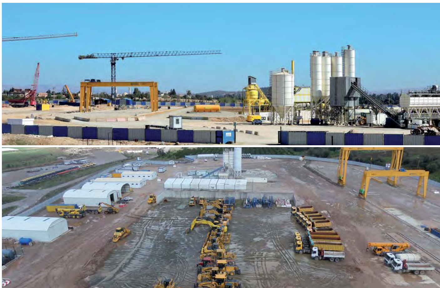
Autopista de conexión al puerto de Ténés Chlef | Argelia
