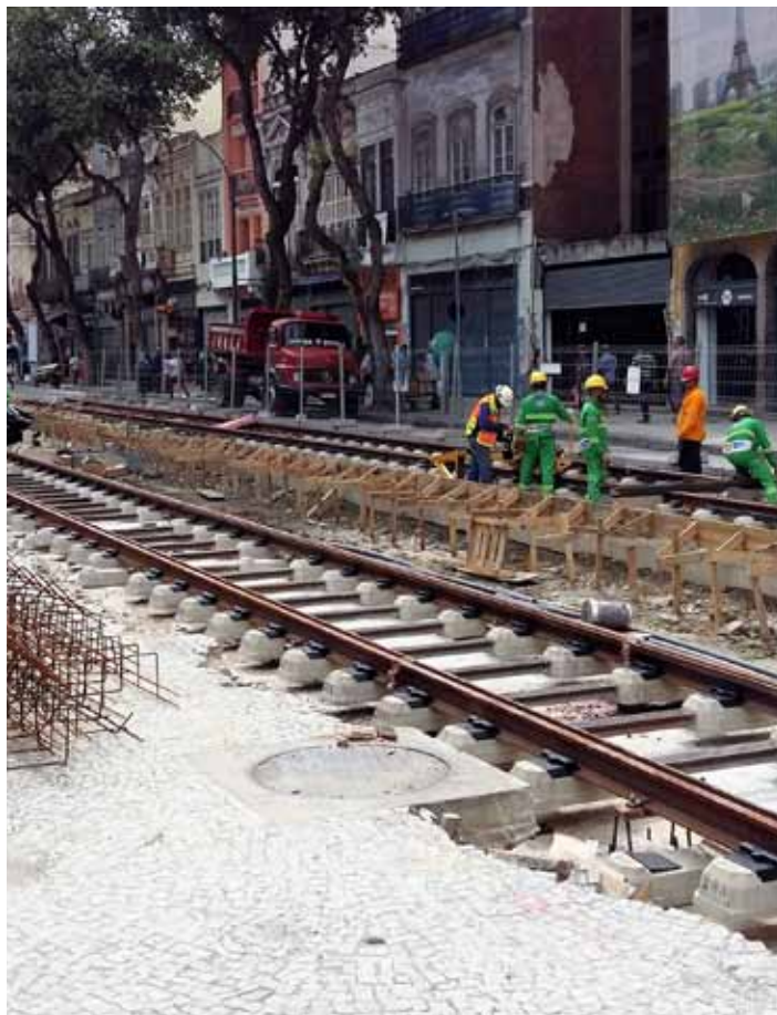
VLT Carioca - Instalação de via de metro ligeiro de superfície Rio de Janeiro | Brasil
