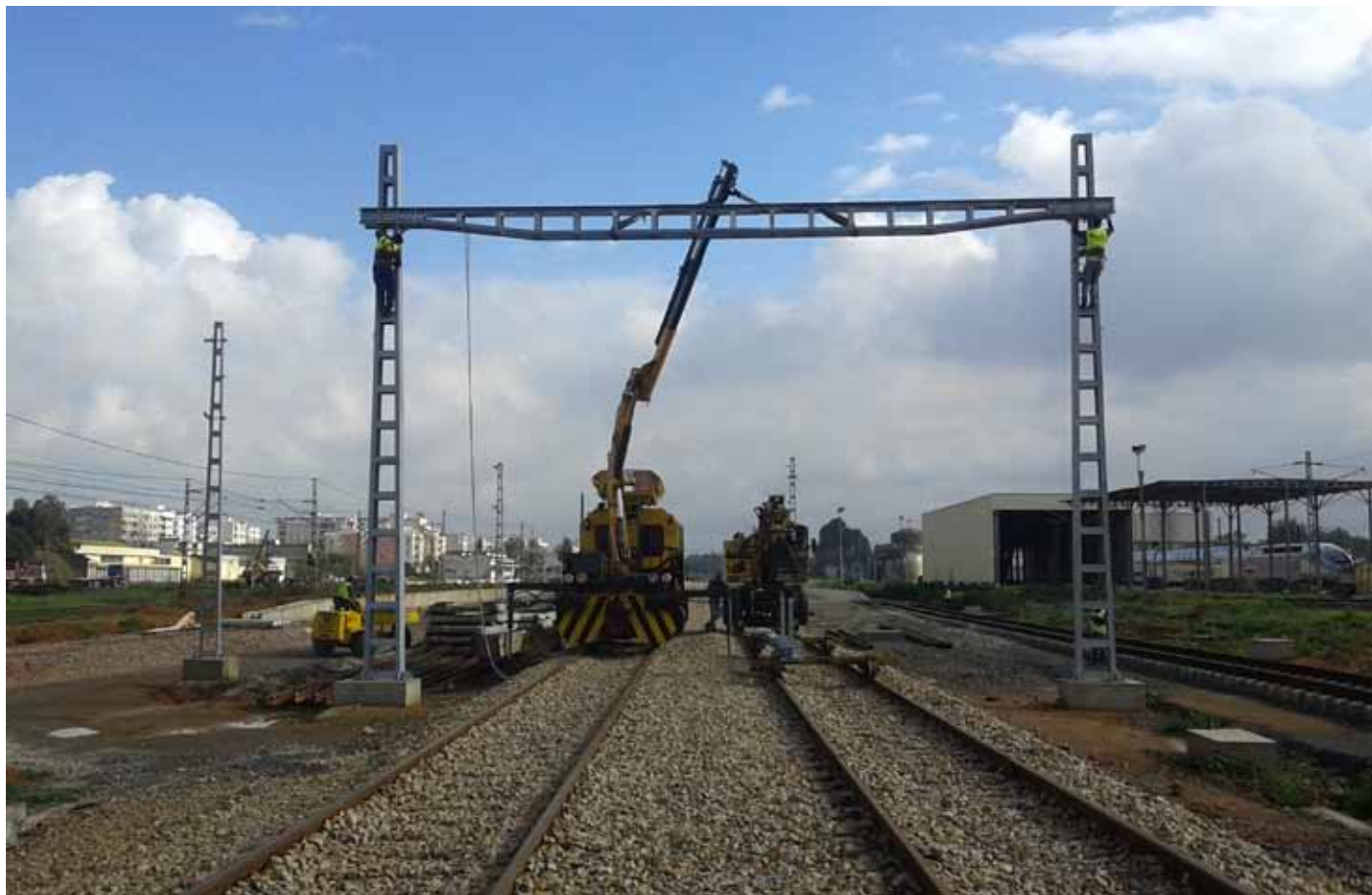
ONCF – Estudos e trabalhos de via, construção civil e catenária, nas instalações terminais de Kenitra Ligação de Alta Velocidade entre Tânger e Kenitra | Marrocos
