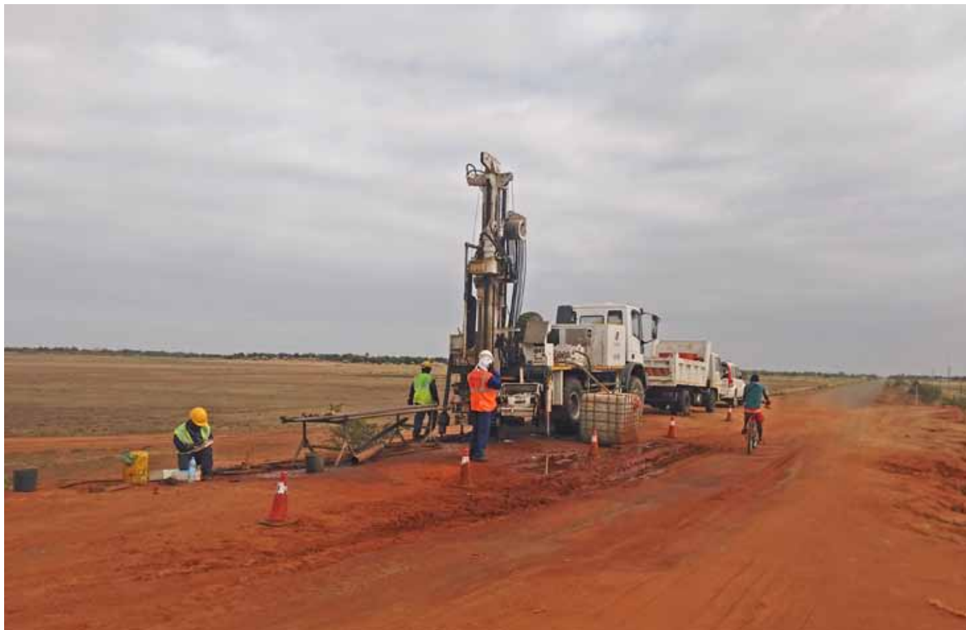
ANE - Trabalhos de sondagens Província de Gaza | Moçambique
