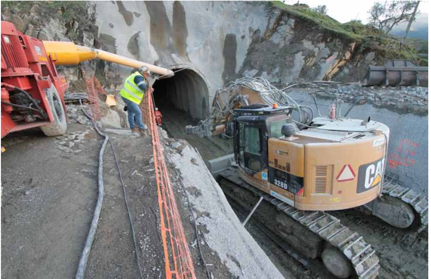
Adega Subterrânea da Quinta do Tedo - Execução de uma galeria subterrânea Folgosa | Portugal
