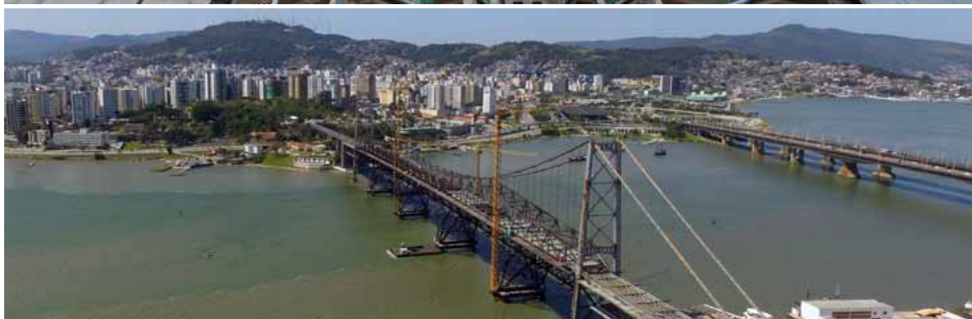
AGB – Sede do Gulf Bank Algeria – Montagem de estruturas metálicas Argel | Argélia
