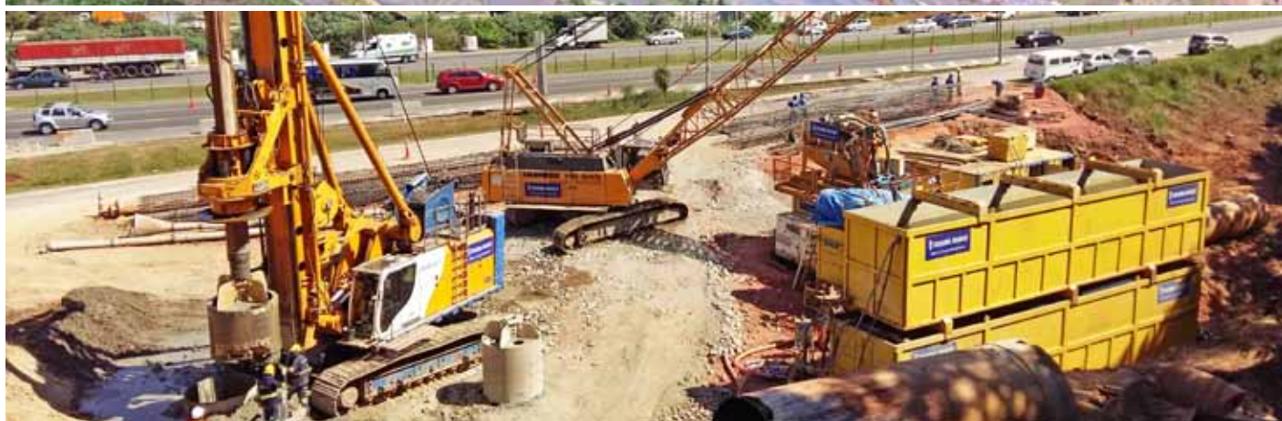
VALE - Estabilização de taludes no Setor Cava Oeste - Mina de Águas Claras, Nova Lima Minas Gerais | Brasil
