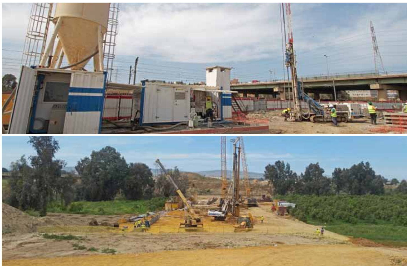
A.P.P.L. – Trabalhos de microestacas e jet grouting Argélia
