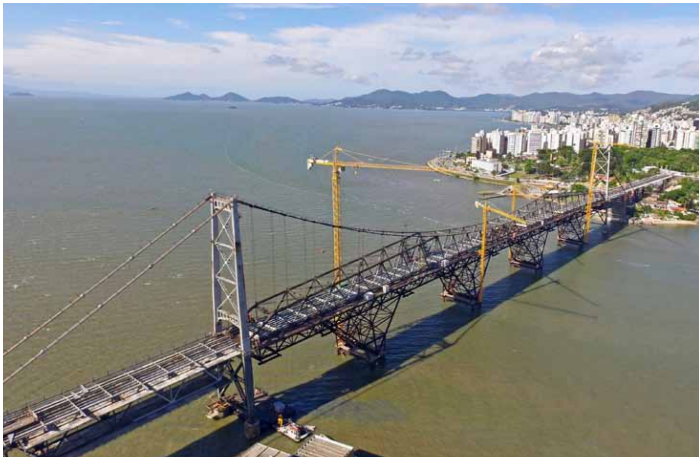
DEINFRA – Restauração e reabilitação da Ponte Hercílio Luz Florianópolis | Brasil
