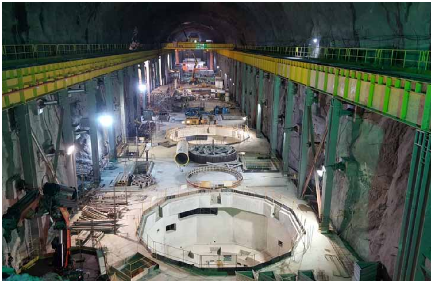
Construtora Norberto Odebrecht – Montagem de diversas estruturas metálicas no Aproveitamento Hidroelétrico de Laúca Kwanza Norte | Angola
