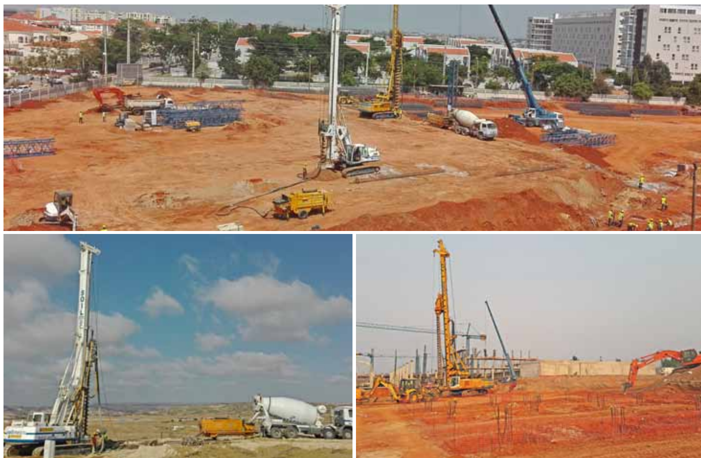
OMATAPALO – Fundações indiretas do edifício Talatona 2 Luanda | Angola
