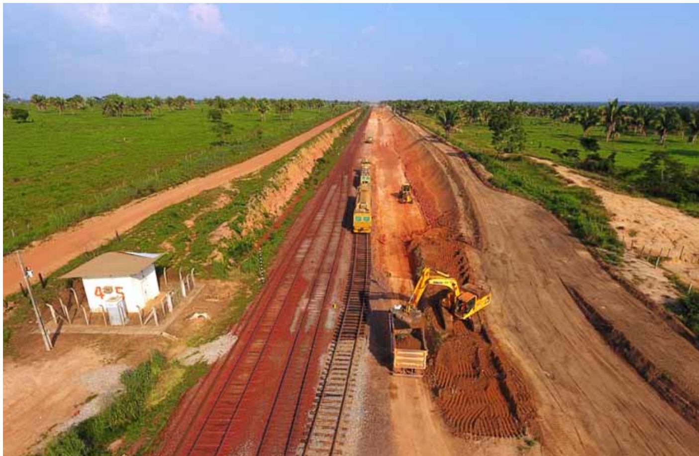
VALE – Expansão da Estrada de Ferro Carajás, bloco G Marabá – Estado do Pará | Brasil
