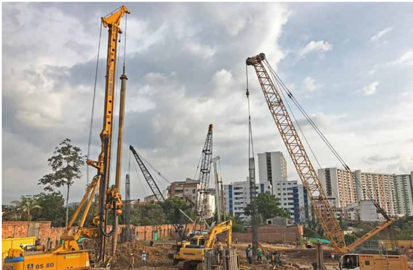
Prabyc Ingenieros - Fundações especiais no empreendimento "Provenza Club" Bucaramanga - Departamento de Santander | Colômbia
