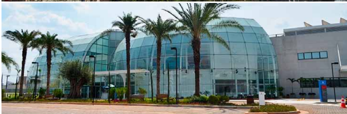
Conselho Europeu - Manutenção de construção civil Bruxelas | Bélgica
