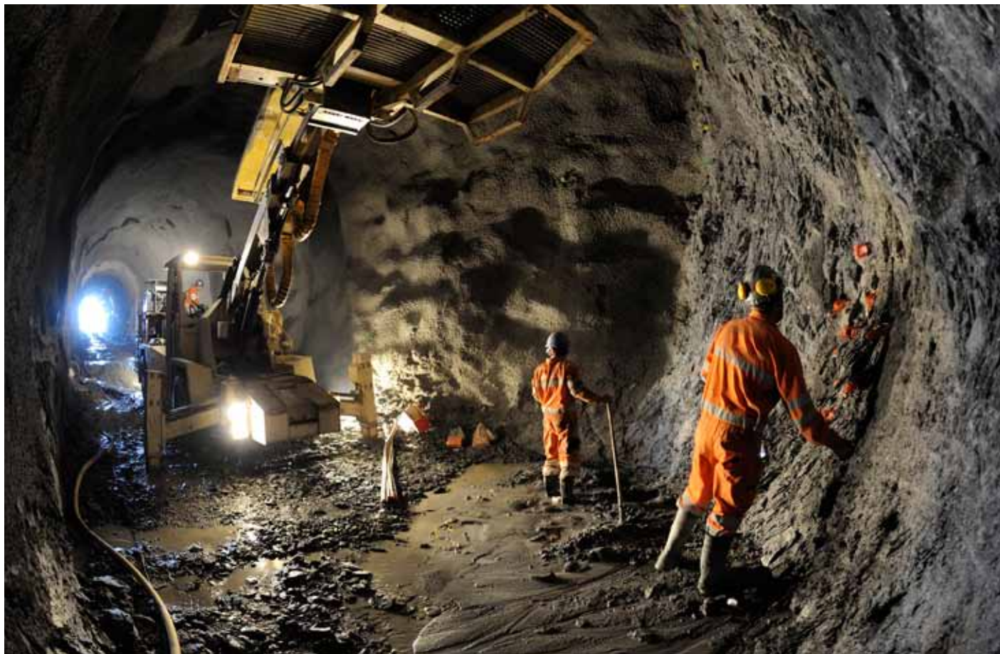
Ferrovial / MSF – Construção da Central de Aspiração e Forçada abaixo da cota 800 – CV04 Sabrosa | Portugal
