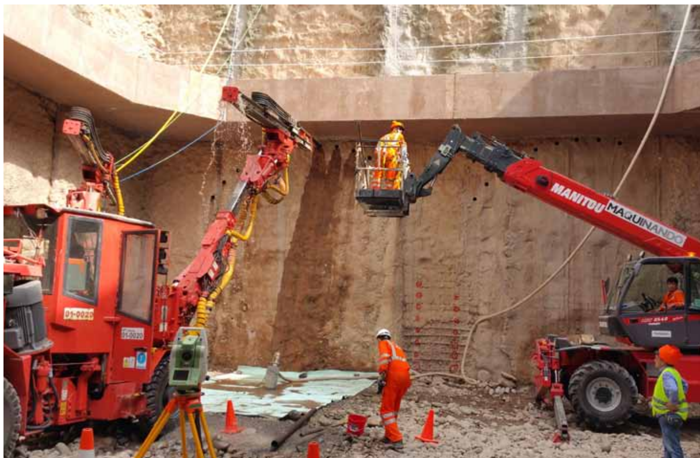
Consórcio Construtor M2 Lima - Escavação e revestimento de duas galerias no Metro de Lima Lima | Peru
