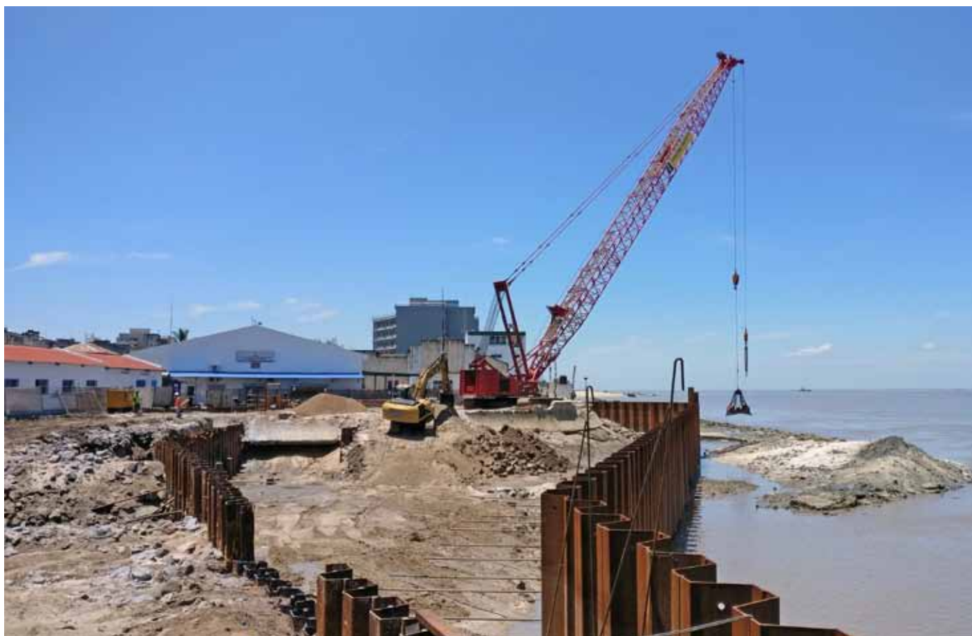
CFM - Trabalhos de geotecnia Porto da Beira | Moçambique
