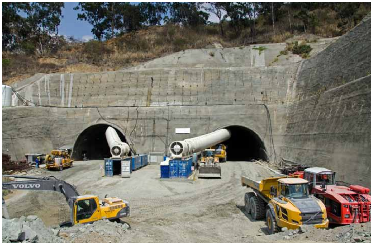
Consorcio Boyacá - La Guaira - Construção do Túnel de Baralt Caracas | Venezuela
