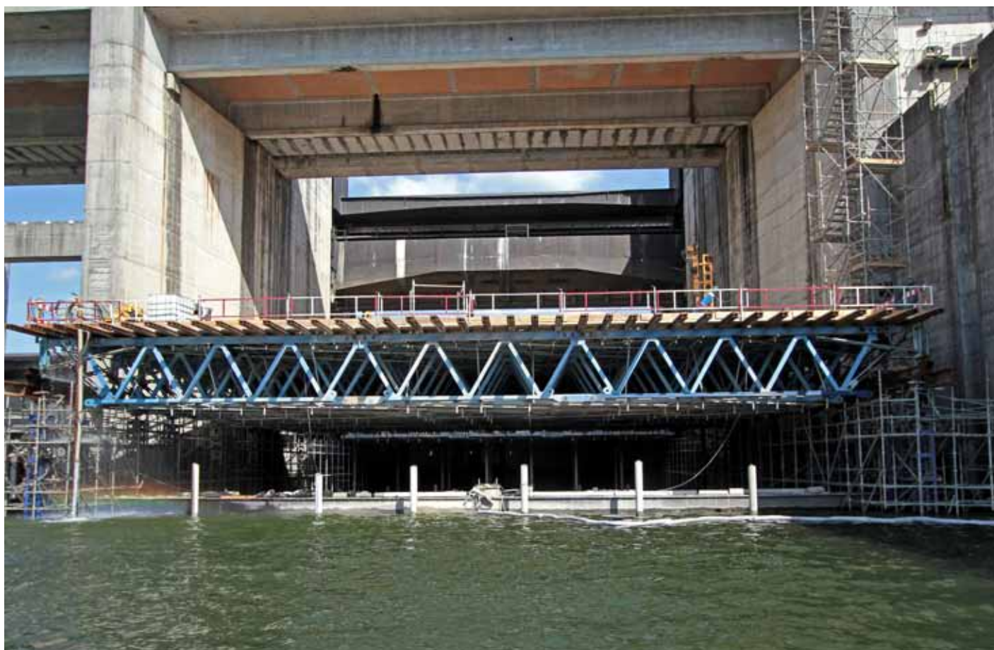
Barragem de Crestuma – Conceção e montagem de uma plataforma para a execução de trabalhos de Geotecnia Porto | Portugal
