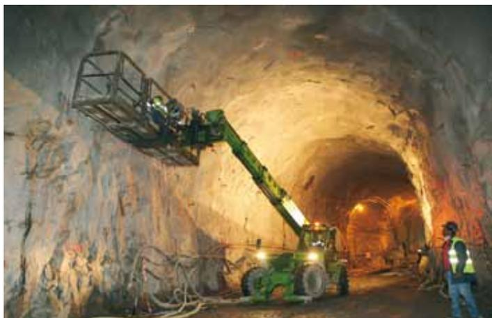
Execução de muro ancorado para a tomada de água e injeções nas enseadeiras da Barragem de Salamonde – Braga
