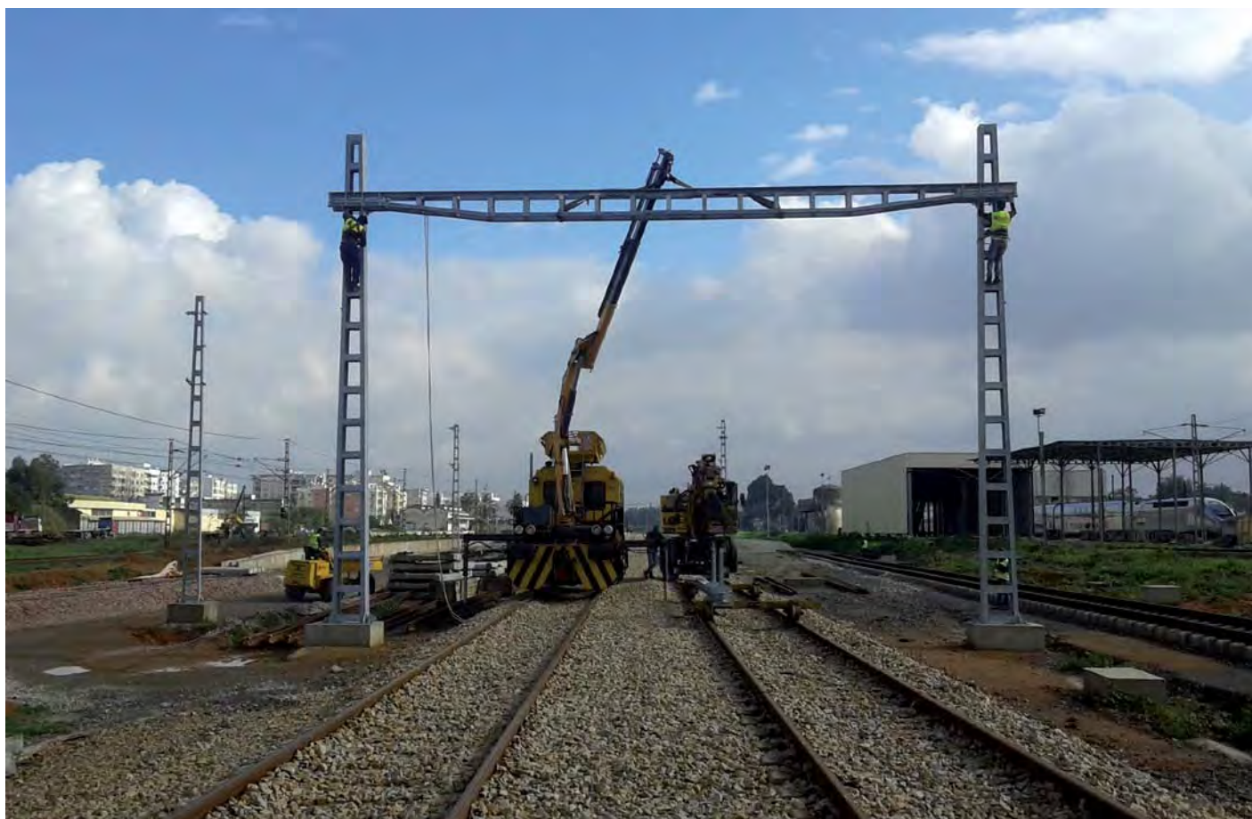
ONCF – Études et travaux de voie, génie civil et caténaire, dans les installations du terminal de Kenitra Ligne à Grande Vitesse entre Tanger et Kenitra | Maroc
