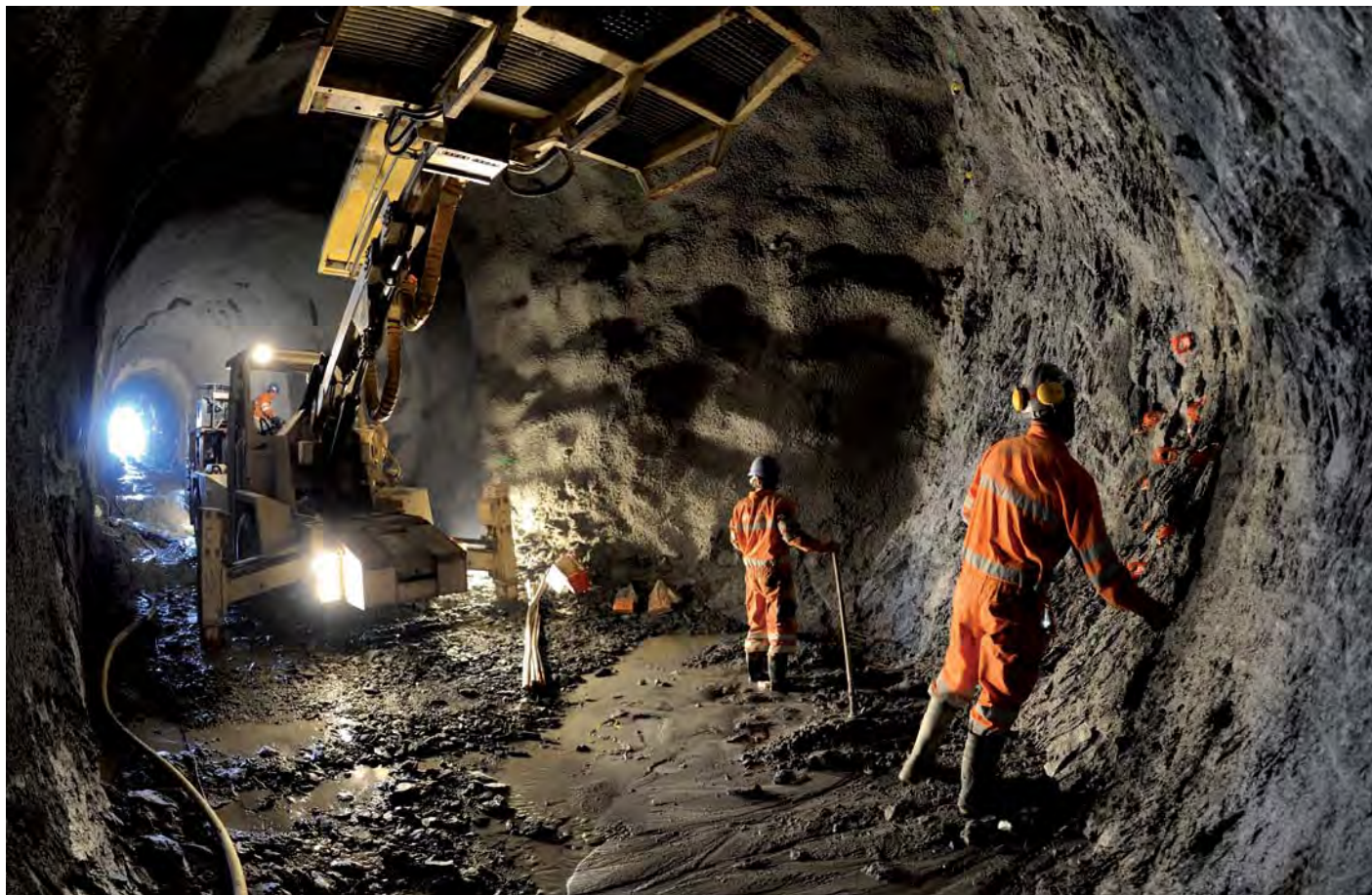
Ferrovial / MSF - Construction de la centrale de pompage et turbinage au-dessous des 800 m - CV04 Sabrosa | Portugal
