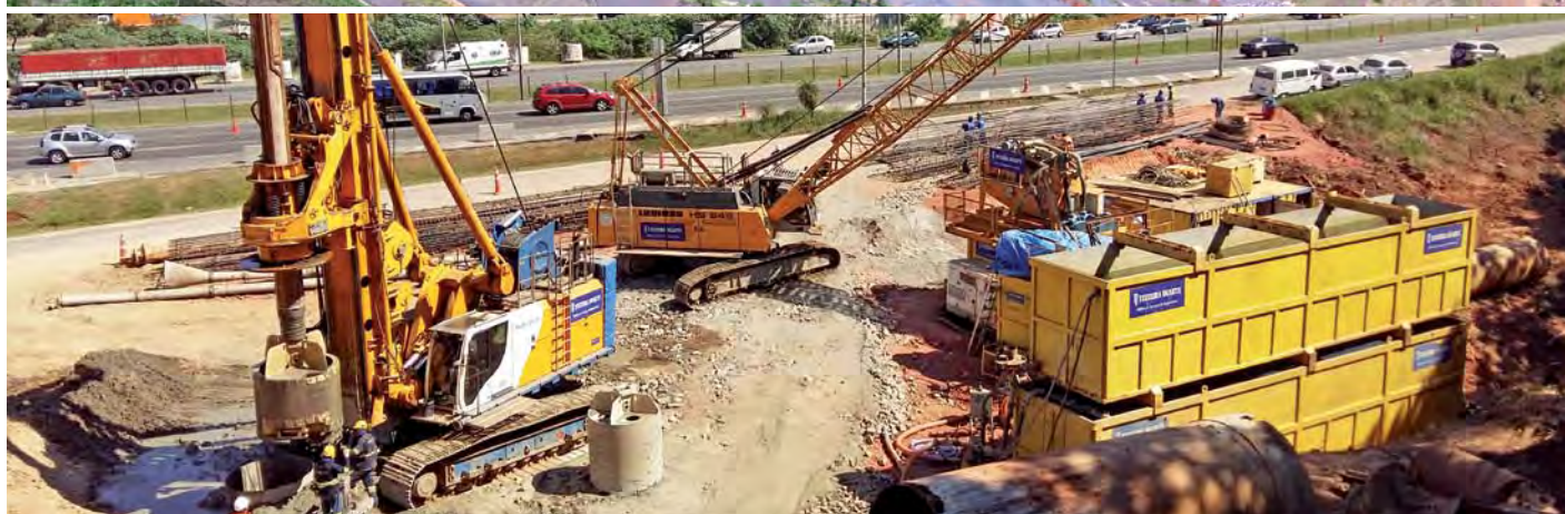
VALE - Stabilisation de flancs de colline dans le secteur Cava Ouest - Mine d'Águas Claras - Nova Lima Minas Gerais | Brésil
