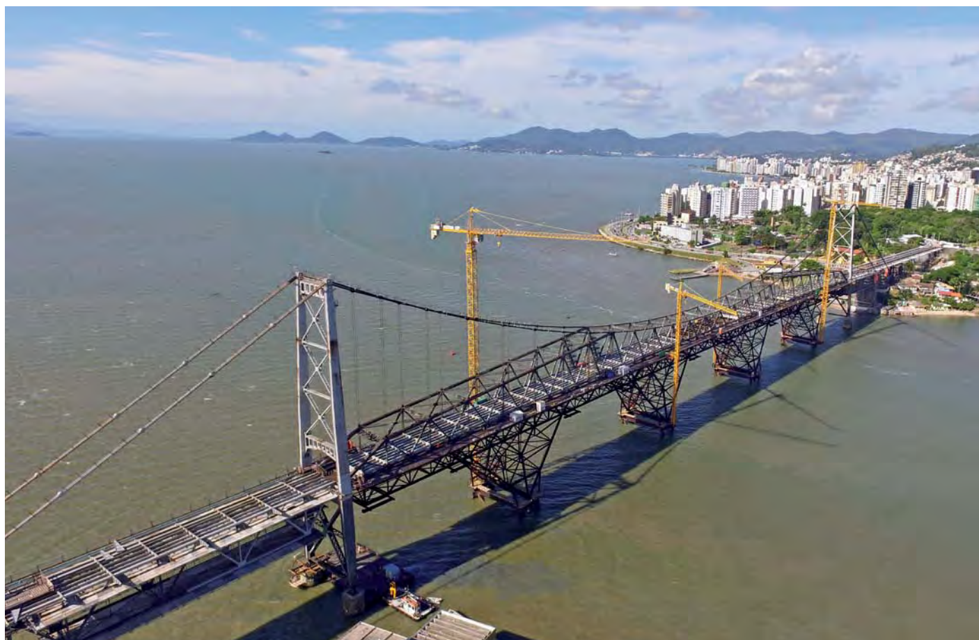
DEINFRA – Restauration et réhabilitation du pont Hercílio Luz Florianópolis | Brésil
