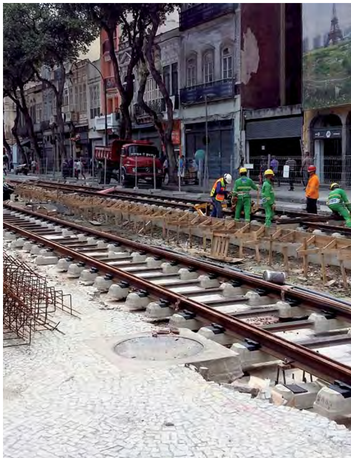
VLT Carioca - Pose de voie du métro léger de surface Rio de Janeiro | Brésil
