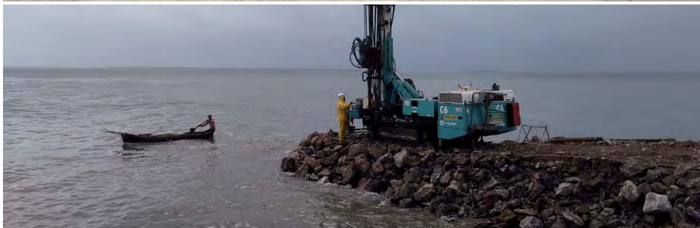
DGRM – Réhabilitation de la jetée orientale du port de Tavira Tavira – Algarve | Portugal
