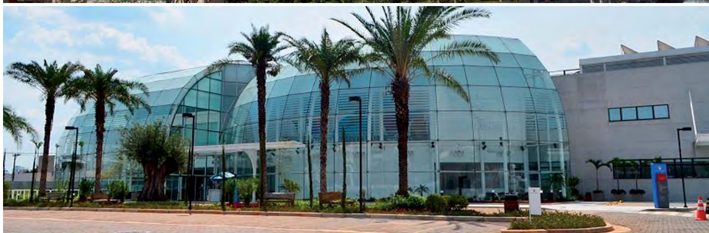
Conseil européen – Maintenance du génie civil Bruxelles – Belgique
