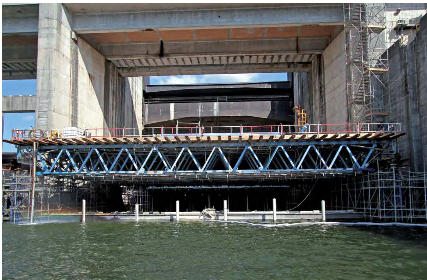
Barrage de Crestuma – Conception et assemblage d'une plateforme destinée à la réalisation des travaux de géotechnique Porto | Portugal
