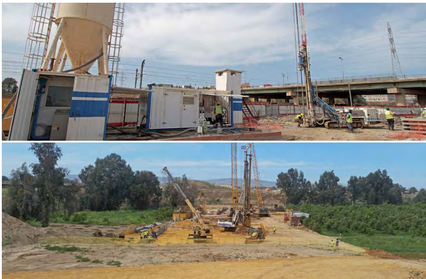
A.P.P.L. – Travaux de micropieux et jet grouting Algérie
