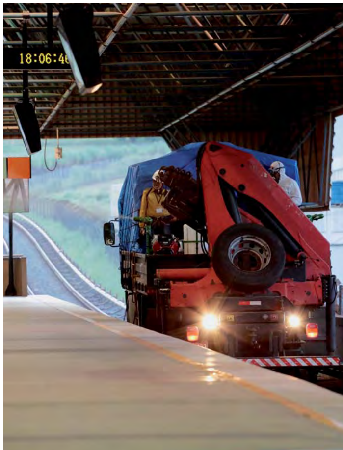
Système métro ferroviaire de Brasília - Prestation de services d'entretien d'urgence Brasília | Brésil
