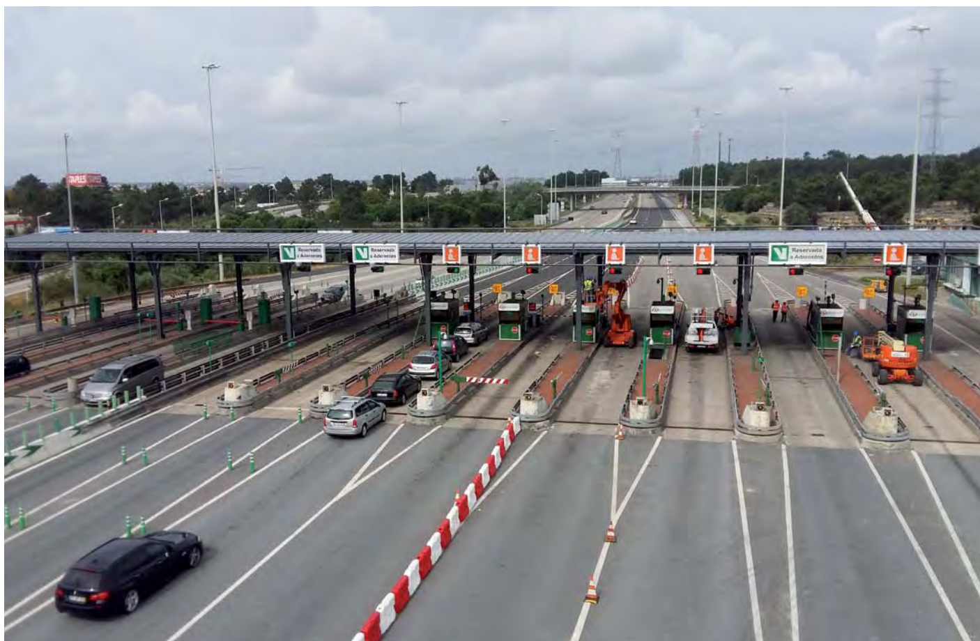
BRISA – Remaniement de l'abri du péage de pleine voie de Coima sur la section Fogueteiro / Coima A2 – Autoroute du sud Portugal
