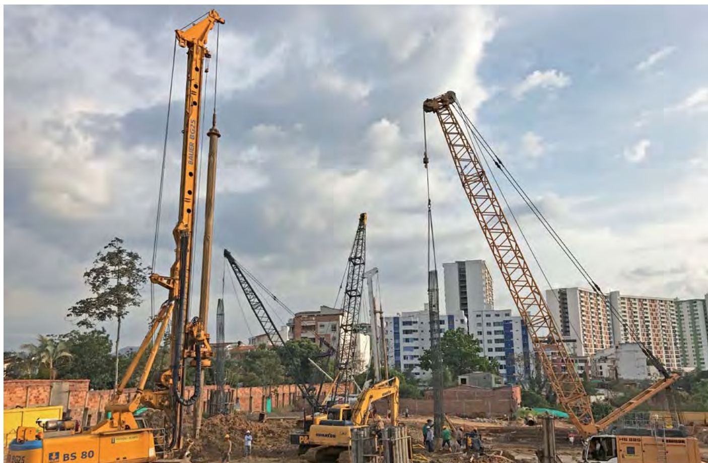
Prabyc Ingenieros - Fondations spéciales dans l'aménagement Provenza Club Bucaramanga - Département de Santander | Colombie
