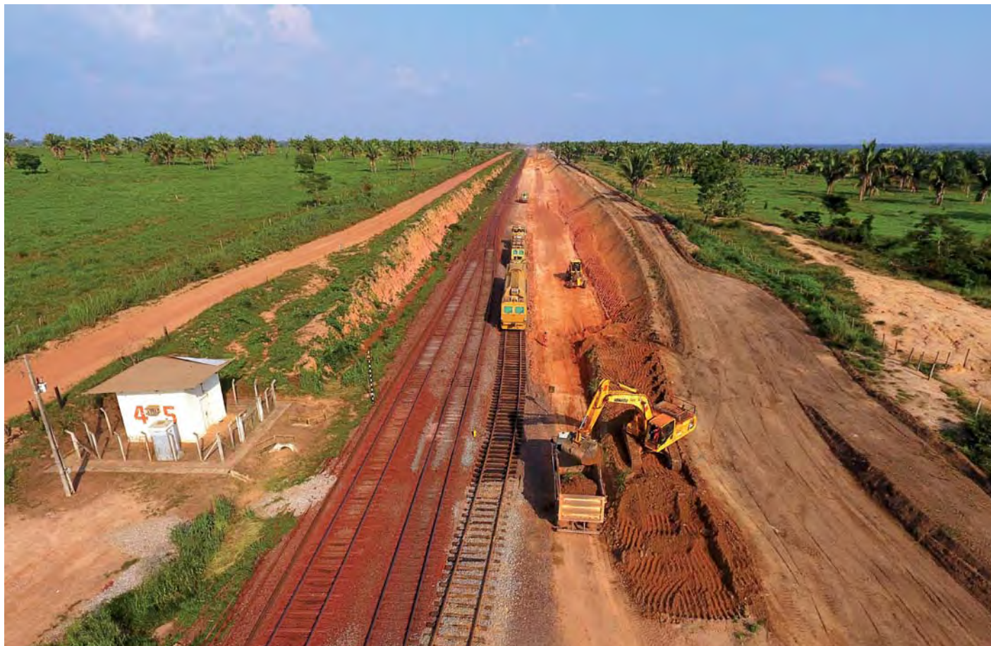
VALE – Extension de la route de Ferro Carajás, bloc G Marabá – État du Pará | Brésil
