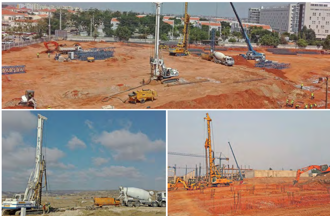
OMATAPALO – Fondations indirectes de l'immeuble Talatona 2 Luanda | Angola
