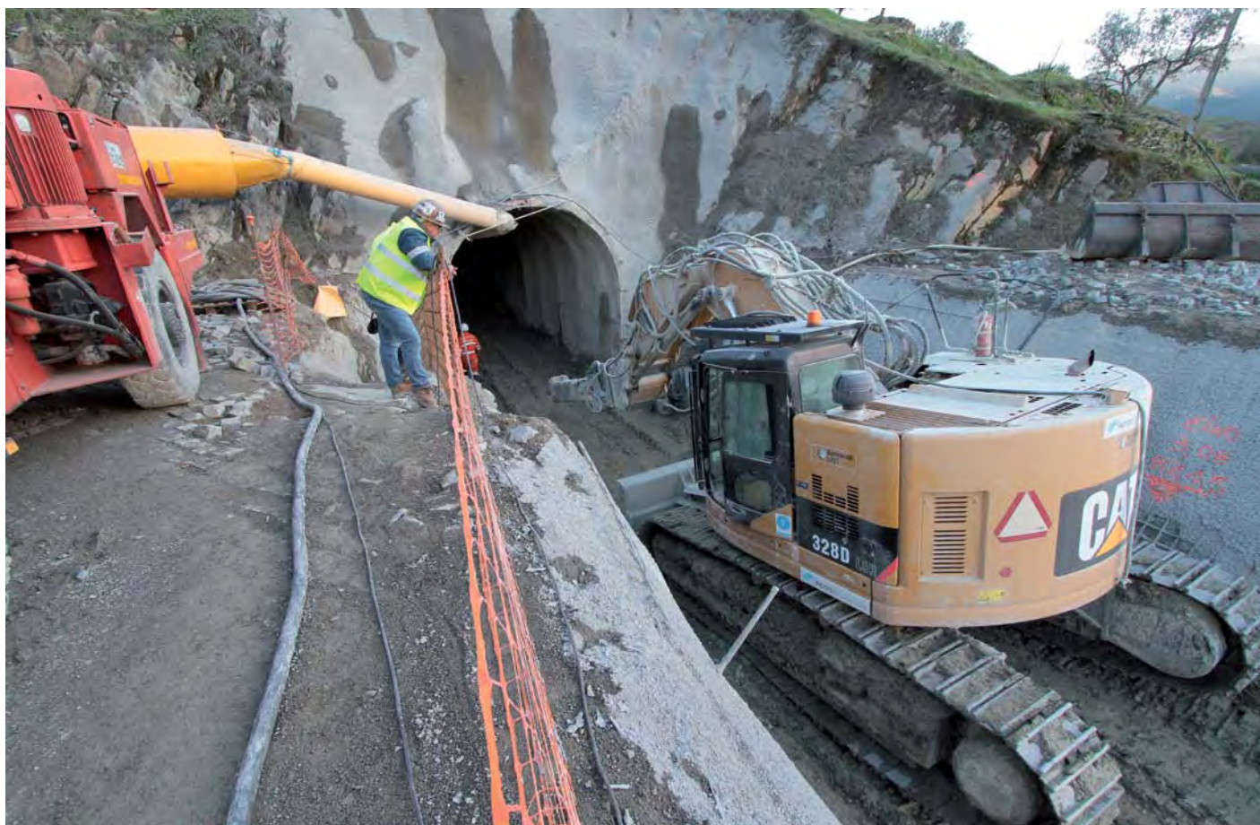
Cave souterraine de la Quinta do Tedo - Réalisation d'une galerie souterraine Folgosa | Portugal
